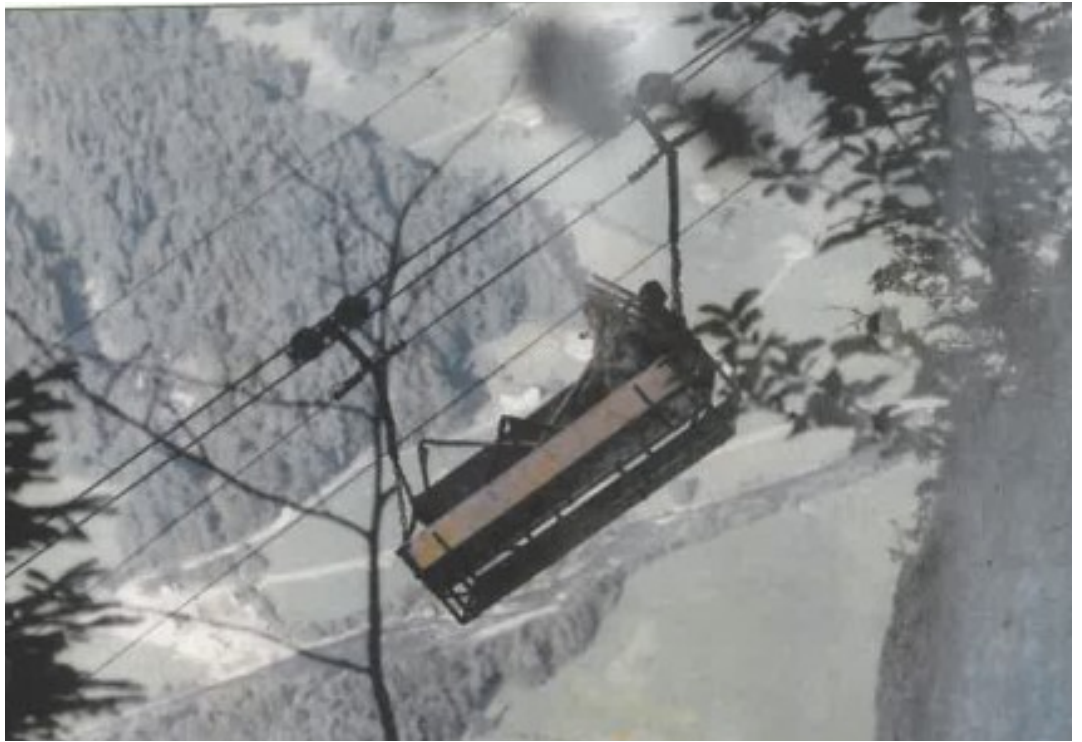
▲ Grossweid Seil: Erstellt im Jahr 1933, vom unteren Schachen in die Grossweid.
