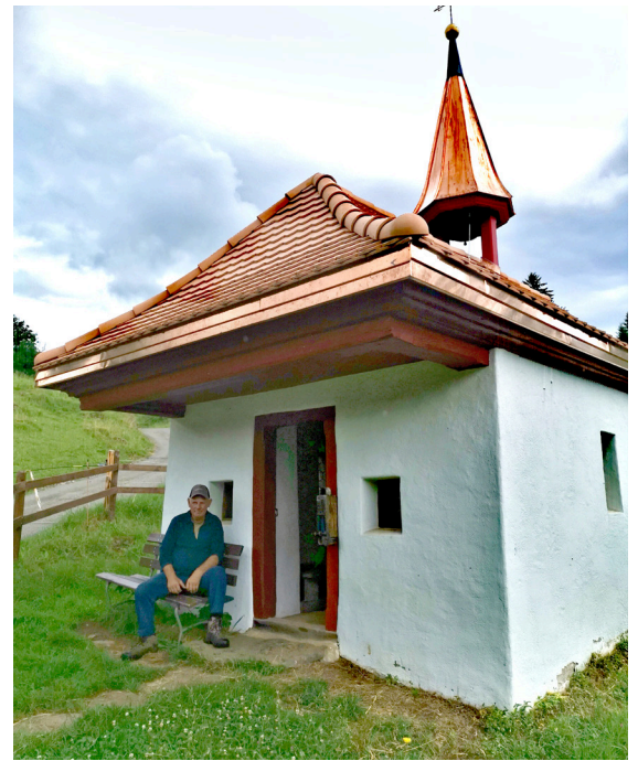
▲ Die Wartkapelle hat ein neues Ziegel- dach bekommen.
