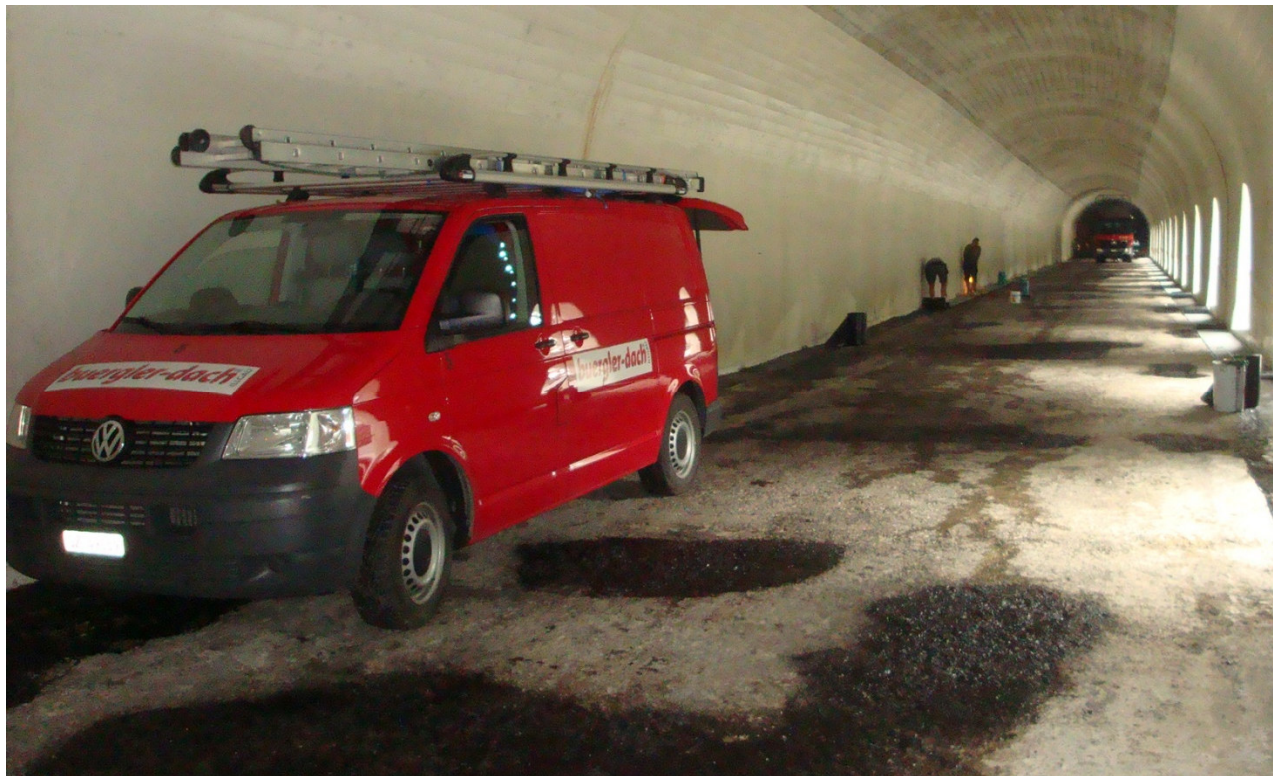
10.08.2016: Die freigelegte Betonplatte in der Galerie wird örtlich instand gesetzt.
