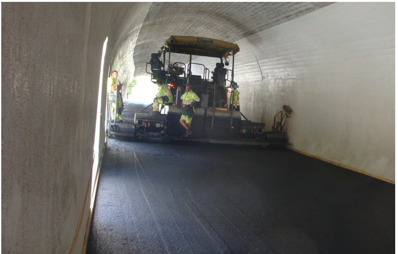
11.08.2016: Deckbelageinbau mit Fertiger in der Galerie
