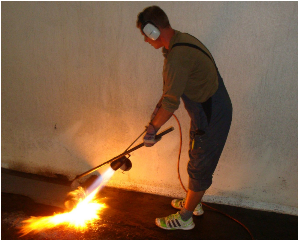
10.08.2016: Aufringen Abdichtungsbahn auf Betonoberfläche
