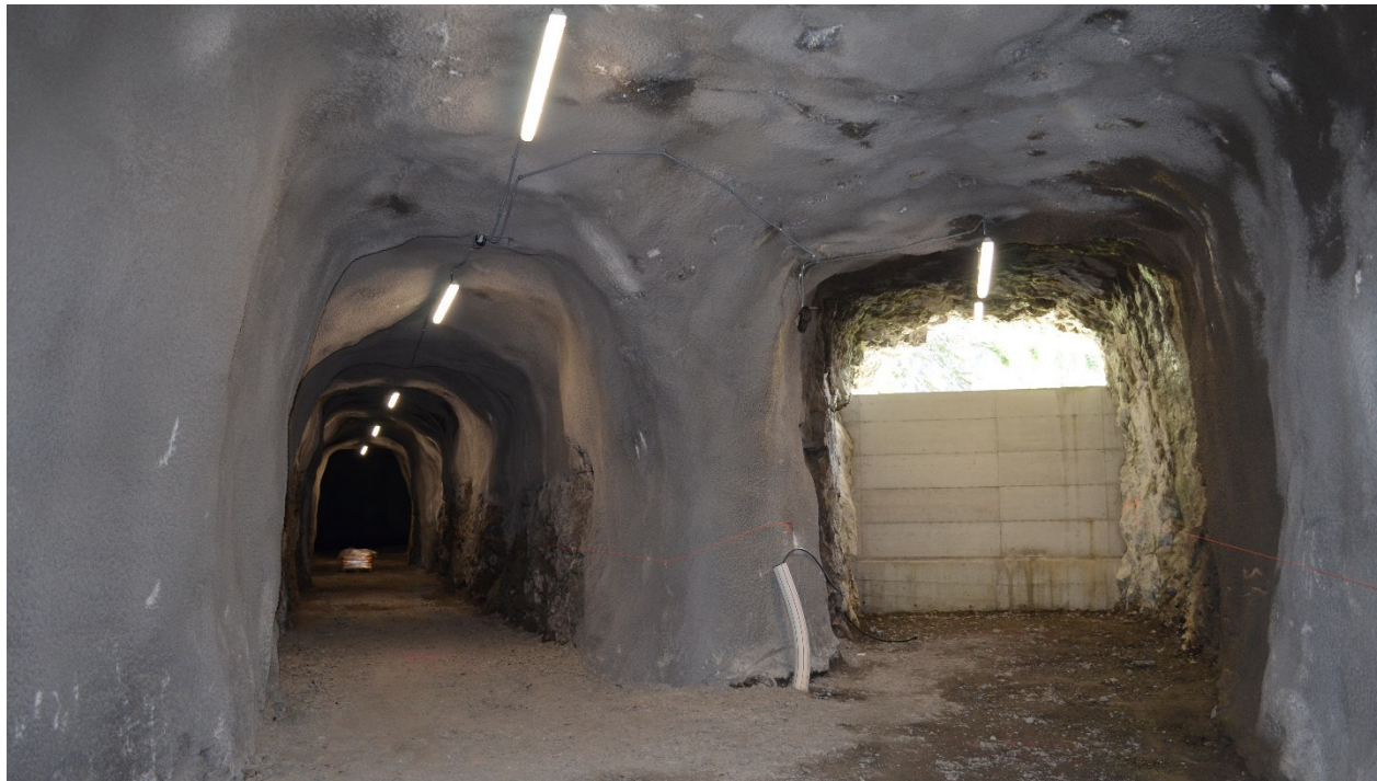
28.07.2016: Fertig erstellte Beleuchtung in den Querstellen, Belag ist noch ausstehend
