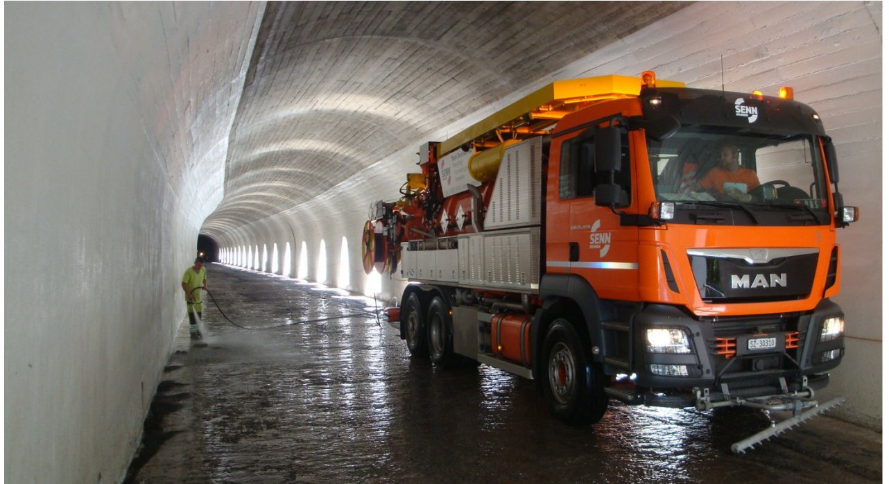
08.08.2016: Nach dem Abtrag des alten Asphalt-Belags wird die Betonoberfläche gereinigt.
