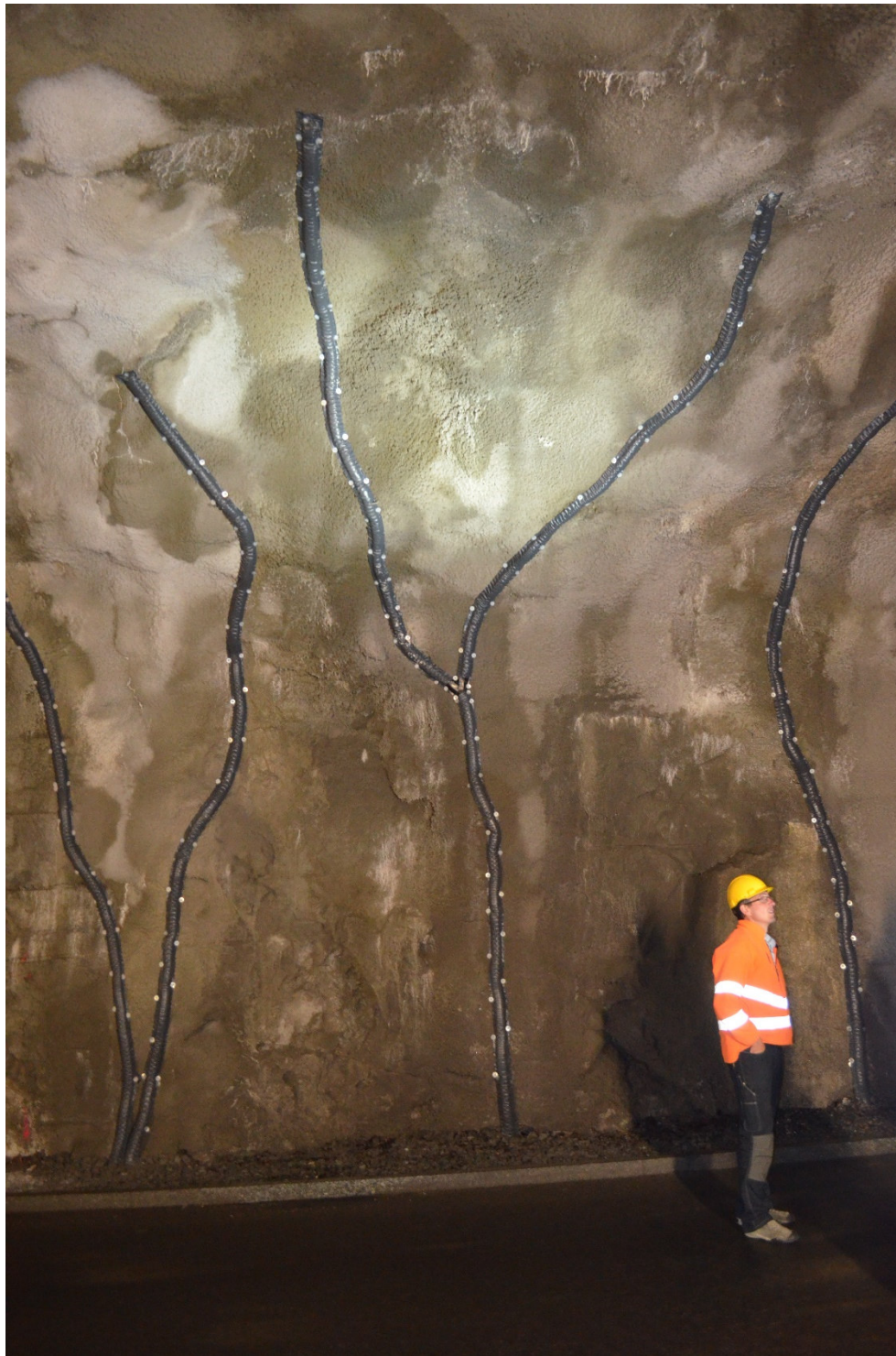
16.06.2016: zusätzliche Abschlauchungen (Fassungen) für Ableitung Tropfwasser im Tunnel
