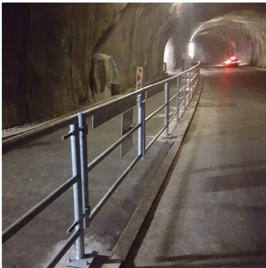
30.08.2016: Rad-/Gehweg parallel zur Tunnel-fahrbahn abgegrenzt mit einem Rohrgeländer
