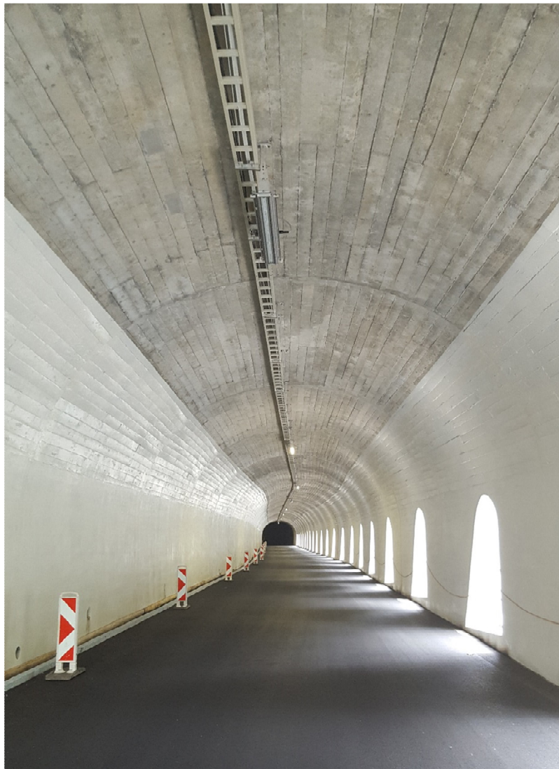
24.08.2016: Fertig erstellte Beleuchtung der Galerie
