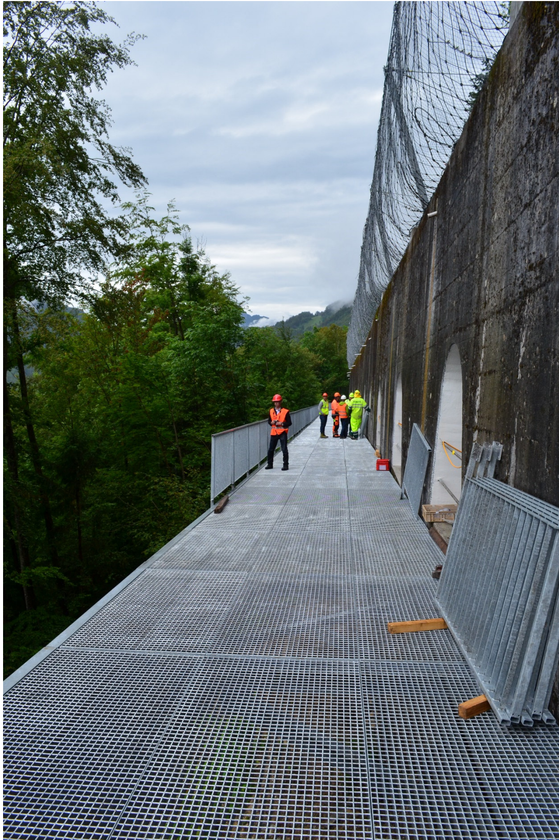
16.06.2016: Montage der Geländer beim Stahlsteg
