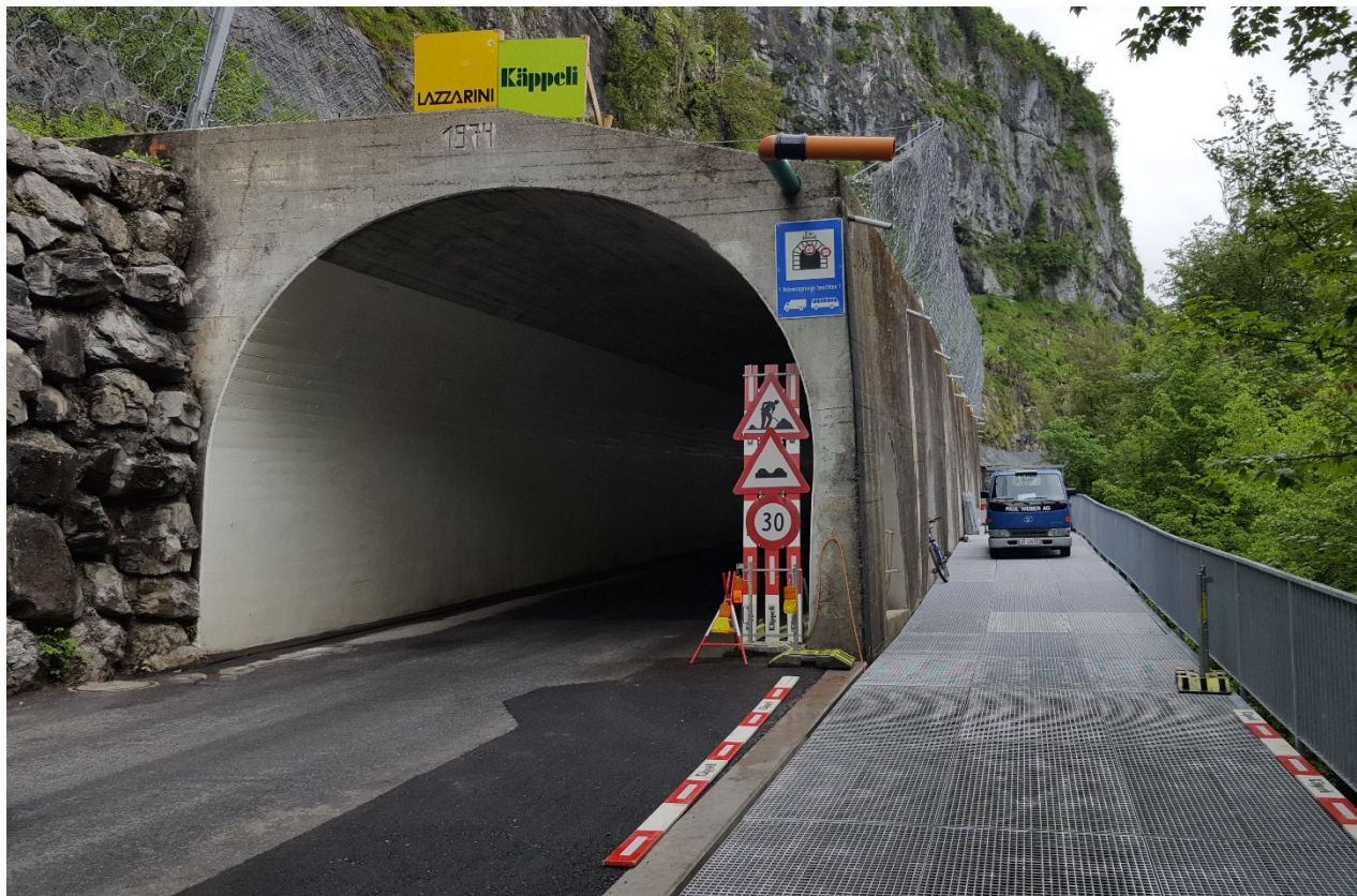
02.06.2016: Teilweise erstellter 3.5 m breiter befahrbarer Stahlsteg für Fussgänger / Radverkehr
