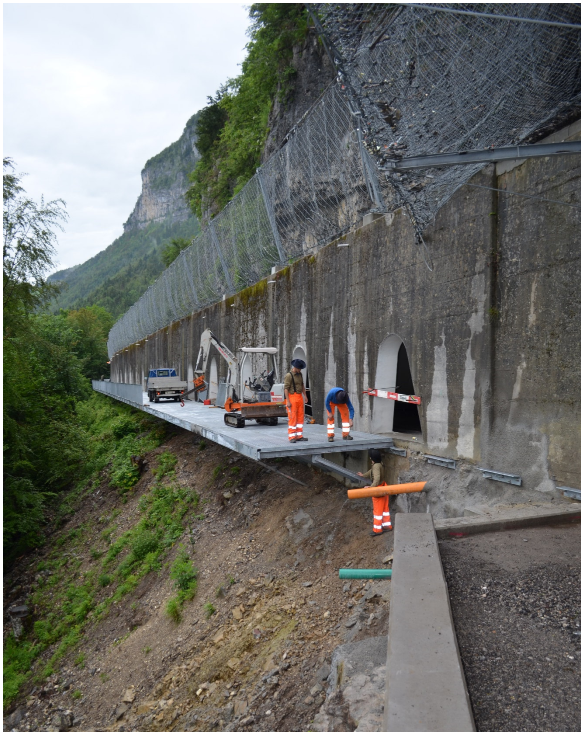
16.06.2016: Stahlsteg beim Anschluss an die alte Illgauerstrasse. Insgesamt wurden 21 to Stahl und 816 Dübel verbaut.
