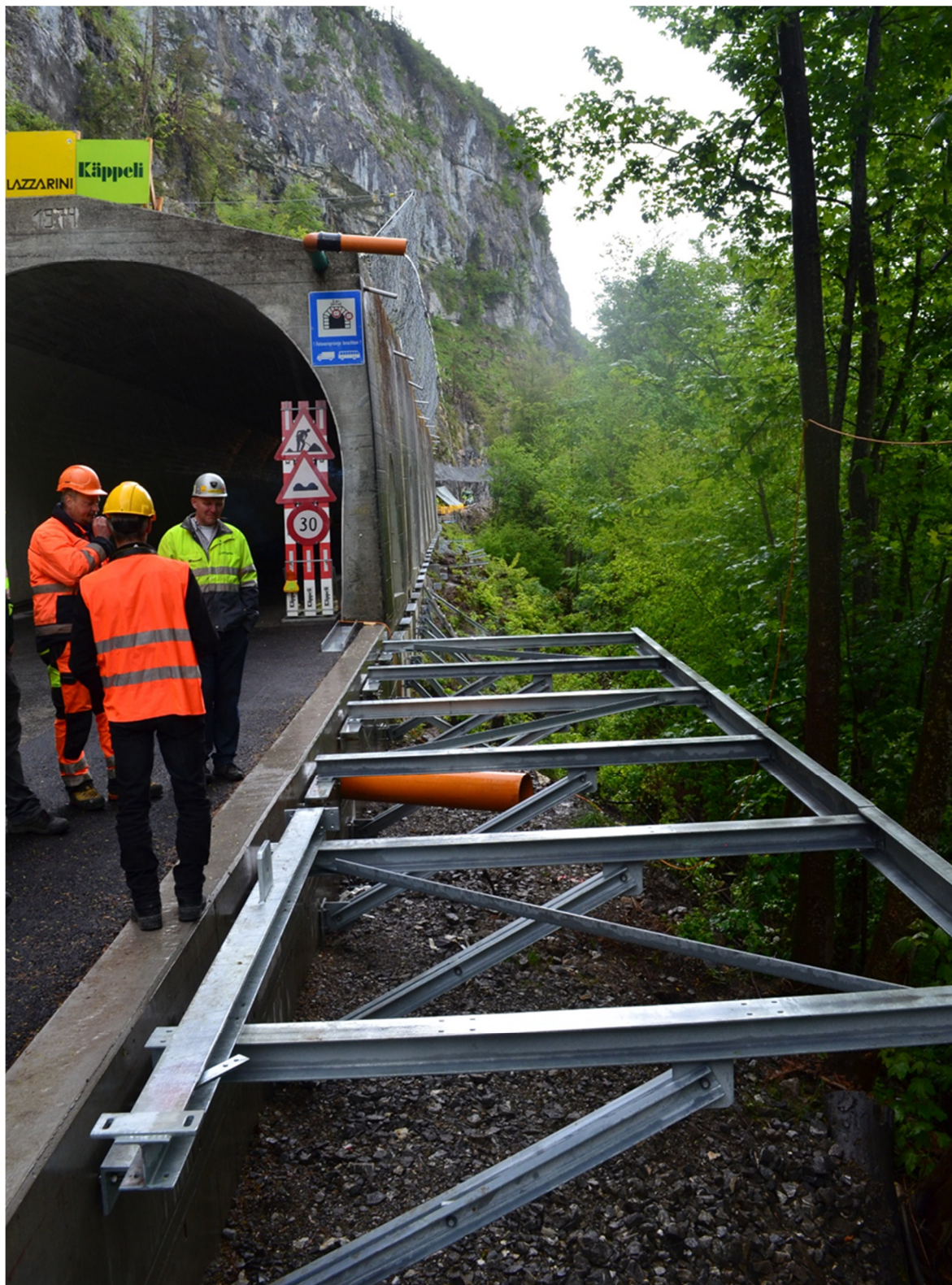
19.05.2016: Montierte Stahlträger und Stützen des neuen Stahlstegs entlang der Galerie für den Rad-/Gehweg.
