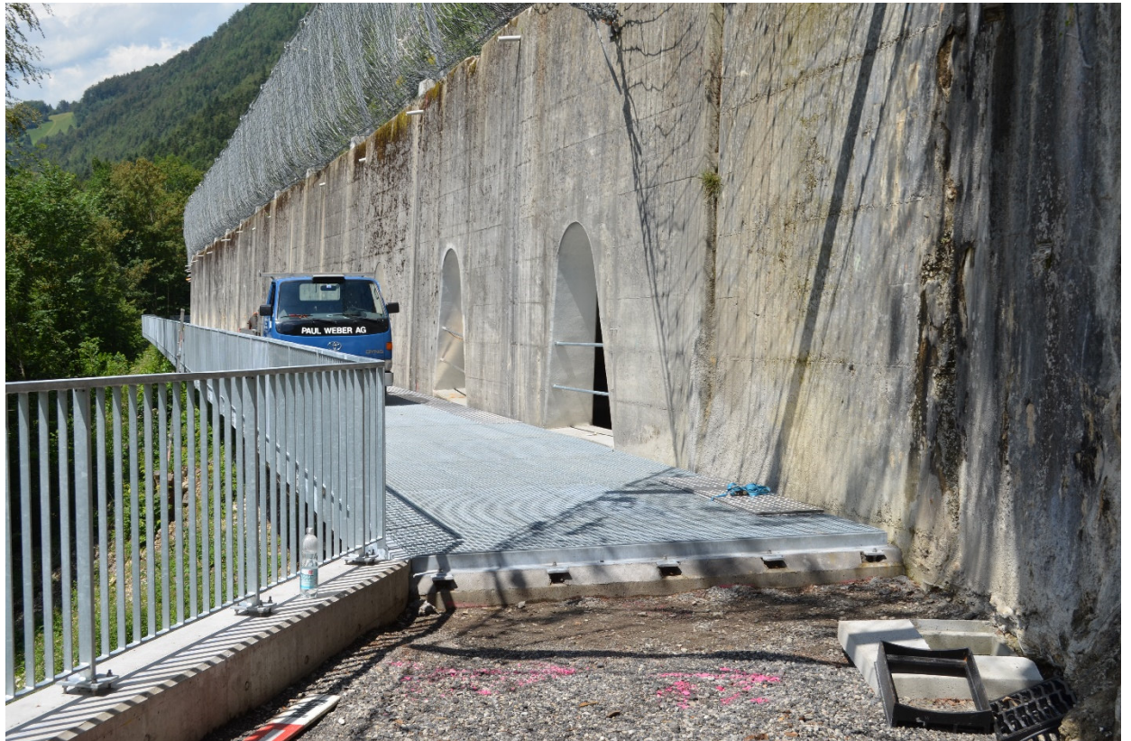
28.07.2016: Fertig erstellter Stahlsteg
