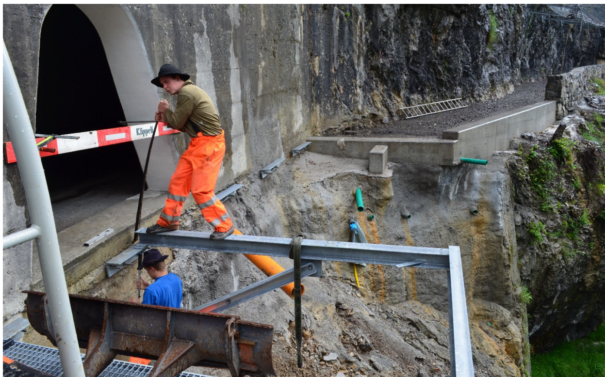
16.06.2016 Montage Stahlsteg kurz vor Anschluss an die alte Illgauerstrasse. Dafür braucht es Schwindelfreiheit, Balance und Kraft.
