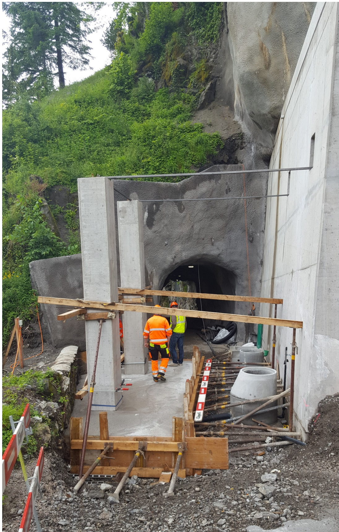
02.06.2016: Neue Fundamente mit vorfabrizierten Beton-Stützen für das Salzsilo neben dem Vortunnel.
