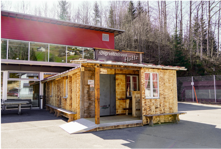
▲ Das Provisorium wurde im Februar erstellt und ist bereit für den Betrieb.
