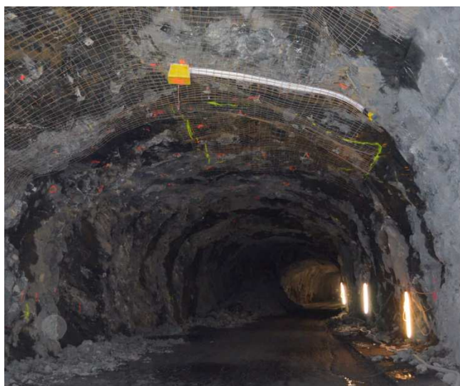
Für den Spritzbeton-Auftrag vorbereitete Tunnelsicherung mit Anker, Netzen sowie Leerrohre für die künftige Tunnelbeleuchtung.
