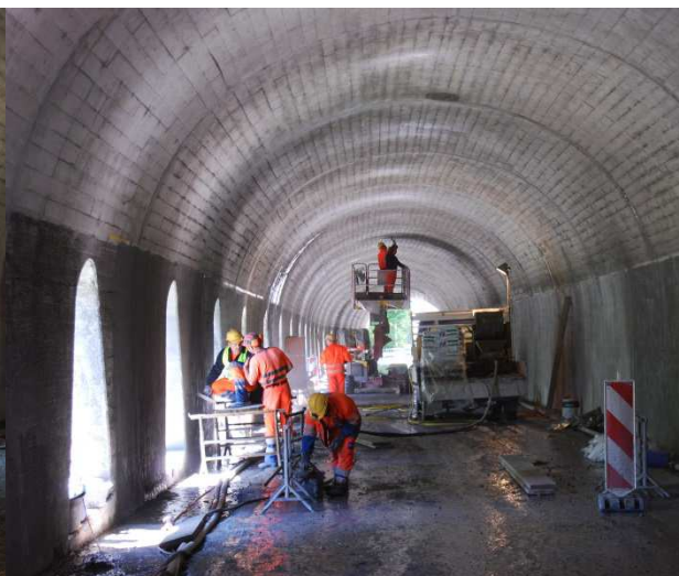
Reprofilieren/Spachtelung der Tunnelwände bis auf ca. 2.5m Höhe über der Fahrbahn.
