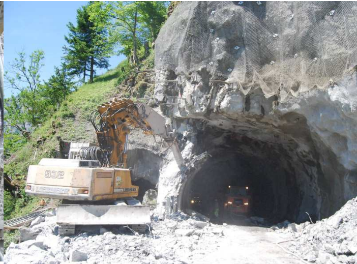
Abbruch des alten Vortunnels unter dem Felsvorsprung.
