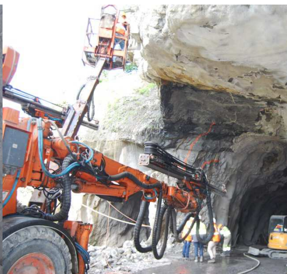
Vorbereitung der Tunnelaufweitung (markiertes Tunnelprofil) im Übergangsbereich zum Vortunnel.
