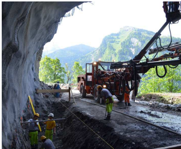
Erstellen eines Fundaments für den neuen Vortunnel.
