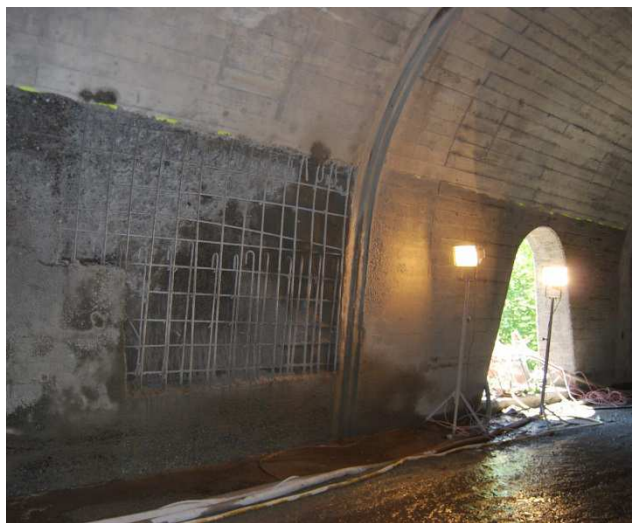
Eine behandelte Schadstelle bereit für die Reprofilierung mit einem Zementüberzug.
