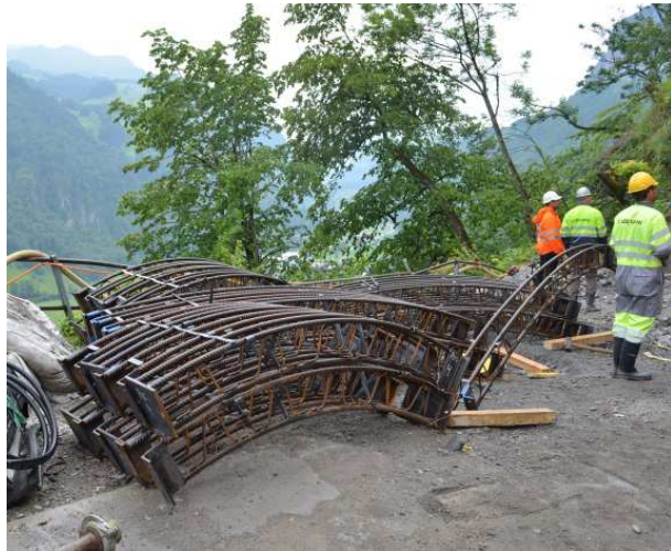
Zwischenlager der Gitterträger-Elemente.
