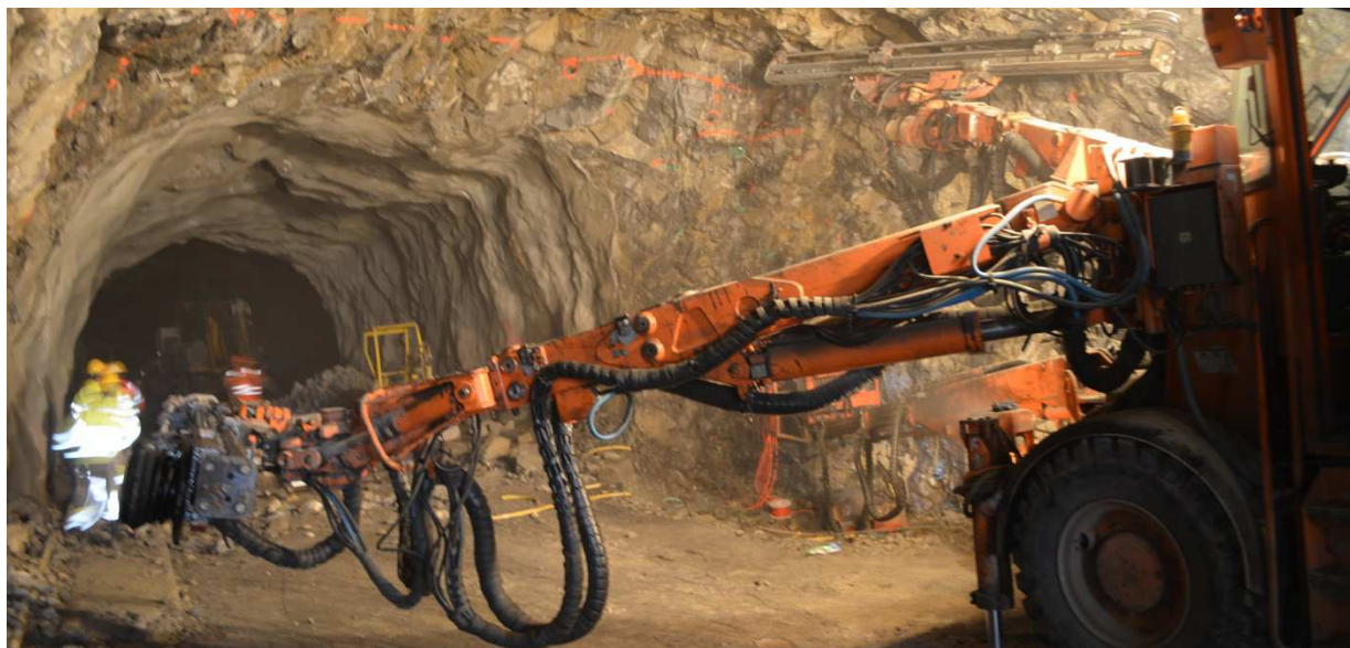
Bohrarbeiten im Bereich des Vortunnels für den Ausbruch der letzten 18m (ca. 5 Abschlüge) Richtung Galerie.
