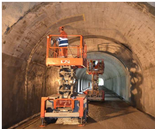
Punktueller Instandsetzung des Galeriegewölbes (Stand 18.6.2015).
