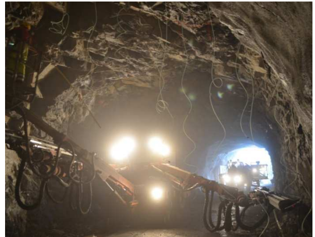
Geladene Sprenglöcher müssen noch verdrahtet werden.
