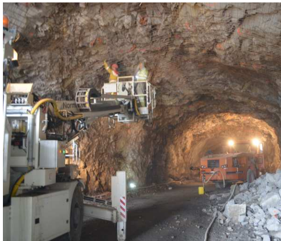
Sichern des Tunnelgewölbes mit Armierungsnetzen, währenddem im Hintergrund für den nächsten Abschlag die Bohrlöcher erstellt und geladen werden.
