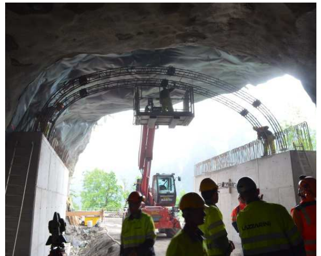
Montage der Gitterträger für die Befestigung der Schalung und Bewehrung des Gewölbes.
