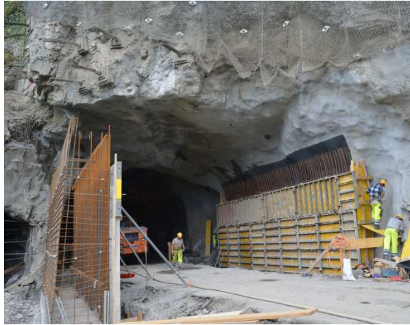
Erstellung der Schalung und Bewehrung der Wände des neuen Vortunnels (Stand 10.6.2015).
