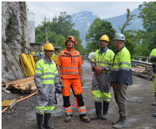
Die Vertreter der Bauherrschaft informieren sich vor Ort über den Stand den Arbeiten.
