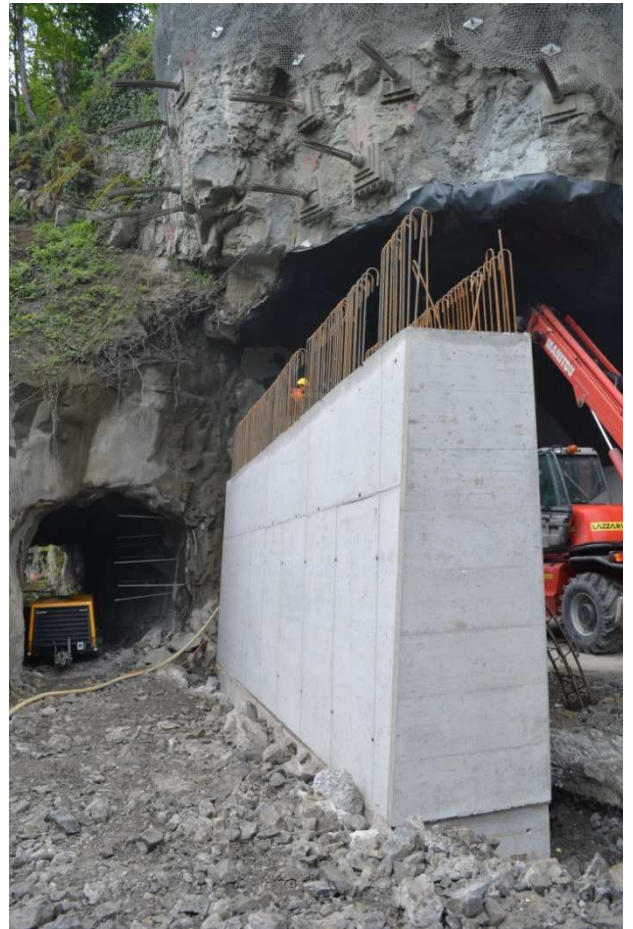
Über die mächtige Seitenwand wird dereinst die Last des Felsvorsprungs abgefangen
