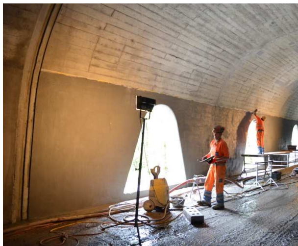
Spachtelung der Seitenwände (Stand 10.6.2015).
