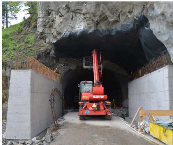
Die Wände des Vortunnels sind betoniert und ausgeschalt. Start der Arbeiten für das Gewölbe des Vortunnels.
