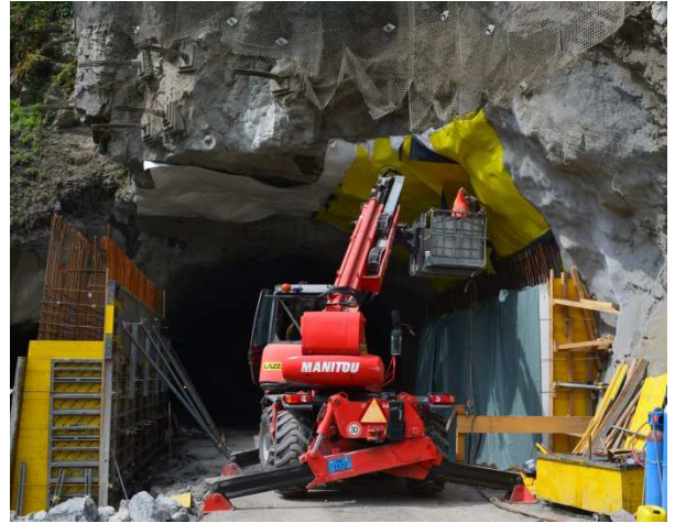
Montage der Abdichtung zwischen Fels und neuem Vortunnel (Stand 12.6.2015).
