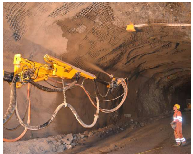
Während im Bereich des Vortunnels die Bohrlöcher geladen und das Tunnelgewölbe gesichert wird, werden im Bereich zur Galerie Spritzbetonarbeiten zur Sicherung des Tunnelgewölbes ausgeführt.
