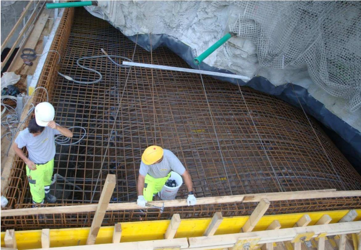
Bewehrung verlegt, zum Betonieren bereit.
