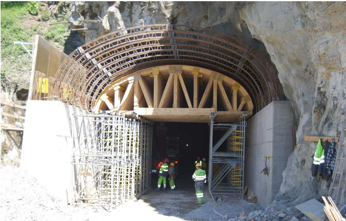
Eingebaute Gewölbeschalung und Bewehrung. Die Gewölbeschalung muss während dem Betonieren die Last von ca.  $170 \text{ m}^3$  Beton ( $\sim 400 \text{ to}$ ) aufnehmen.
