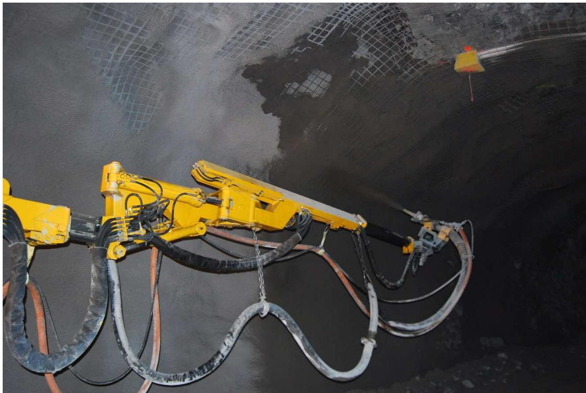
Abschluss der Tunnelsicherung mit Spritzbeton. Der Beton wird mit ca. 2'000 bar auf die Bewehrung gespritzt und bleibt dadurch „kleben“.
