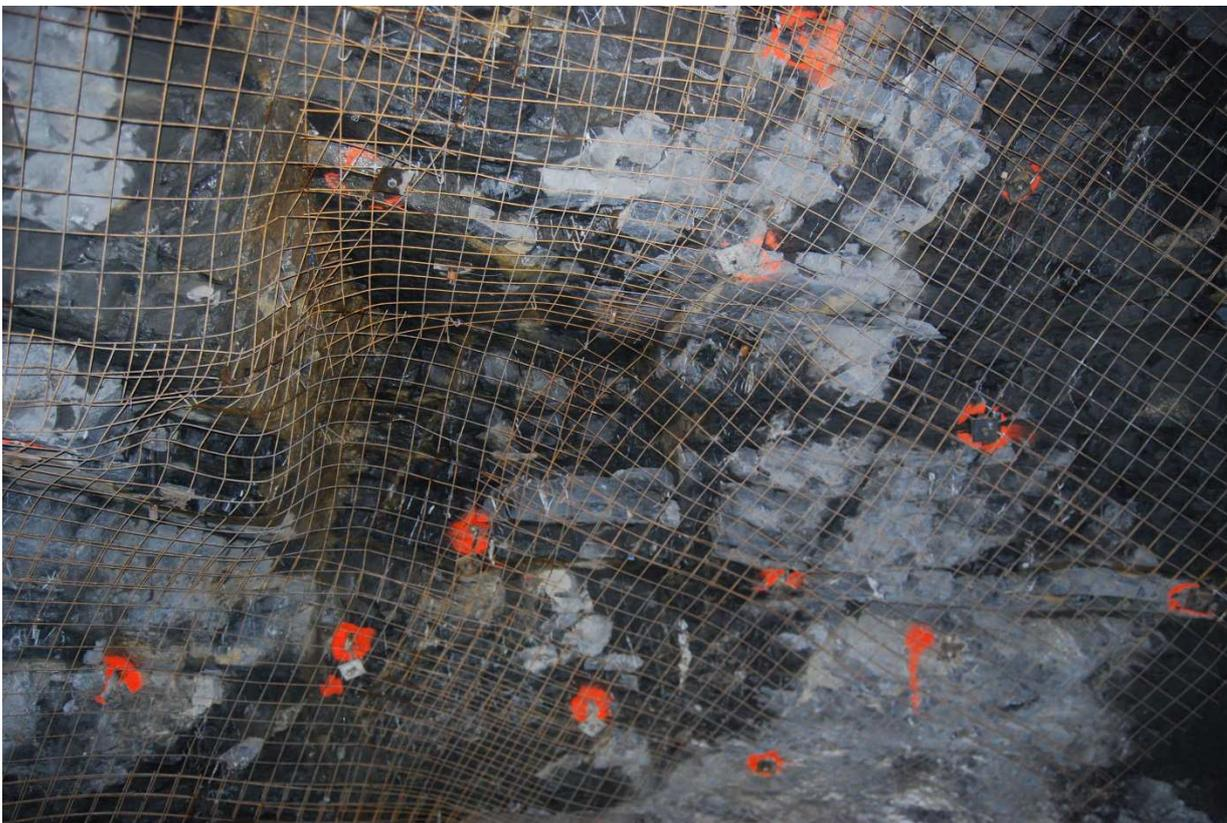
Die Anker (rot) und Bewehrungsnetze für die Sicherung des Tunnelgewölbes werden anschliessend mit Spritzbeton gefestigt.
