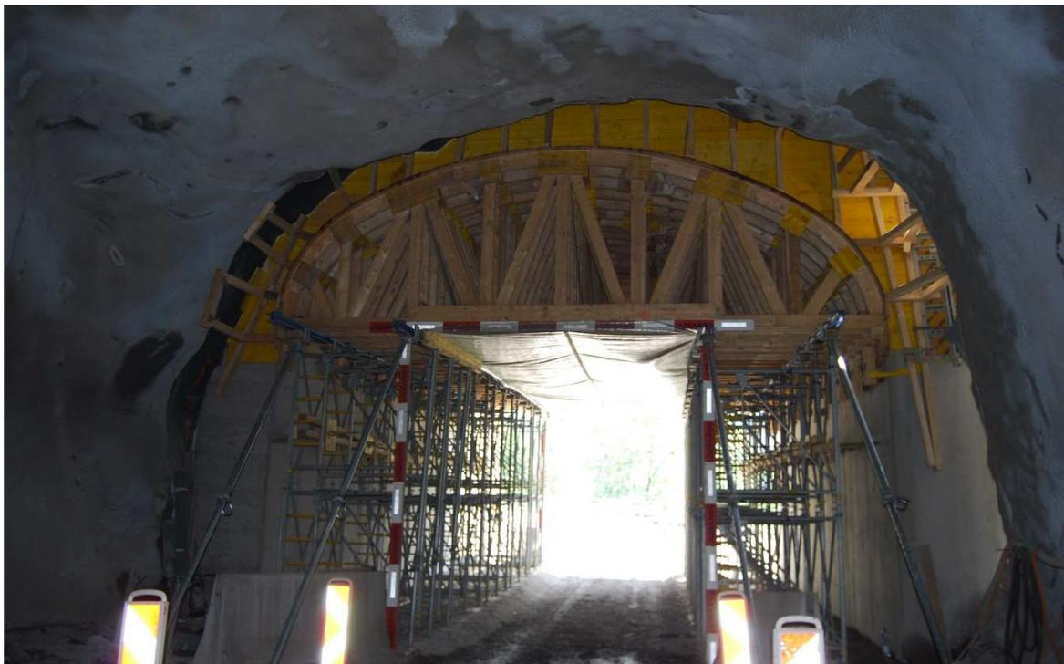
Abgestützte Gewölbeschalung mit einspuriger Durchfahrtsgasse für den Verkehr.
