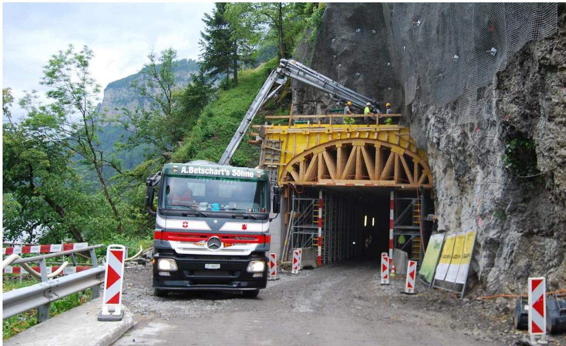
Während ca. 8 – 10 Stunden wird unter Verkehr betoniert. Für den Einbau der ca. 170 m<sup>3</sup> Beton sind ca. 25 Fahrmischer erforderlich. Der Beton wird gepumpt.
