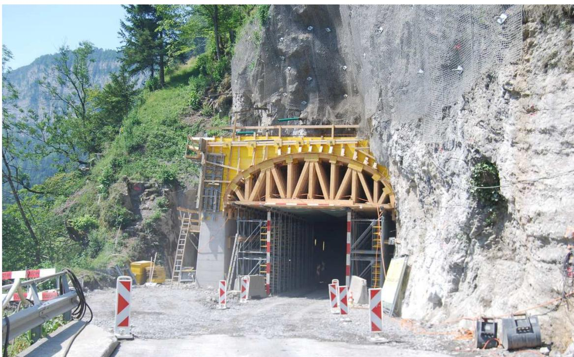
Fertig erstellte Gewölbeschalung. Damit die Durchfahrt unter der Schalung für LKWs möglich ist, hat die ARGE die Illgauerstrasse um ca. 70 cm abgesenkt.
