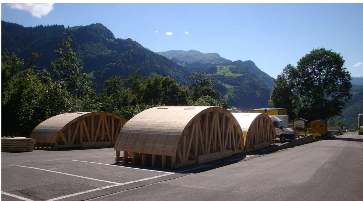
Die gelagerten Schalungs-Elemente für das Gewölbe des neuen Vortunnels sind bereit für den Einbau.
