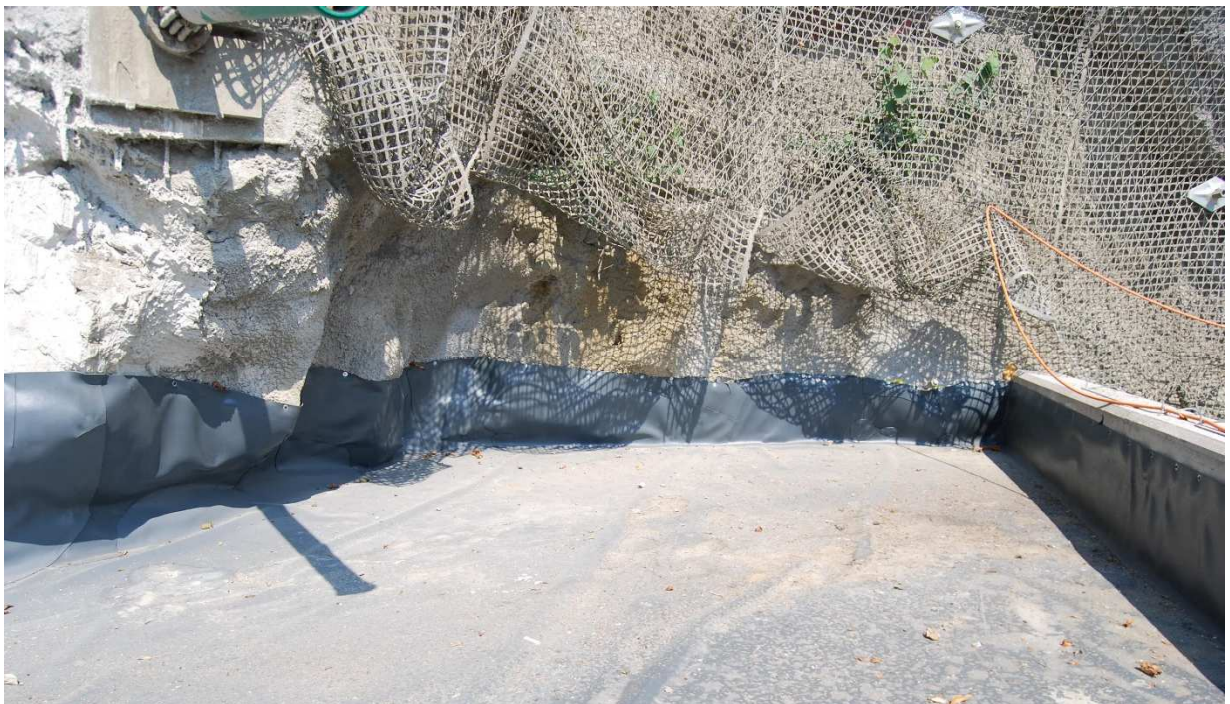
Die Abdichtung auf dem Gewölbe des Vortunnels ist erstellt und bereit für den Einbau des Schutzbetons.
