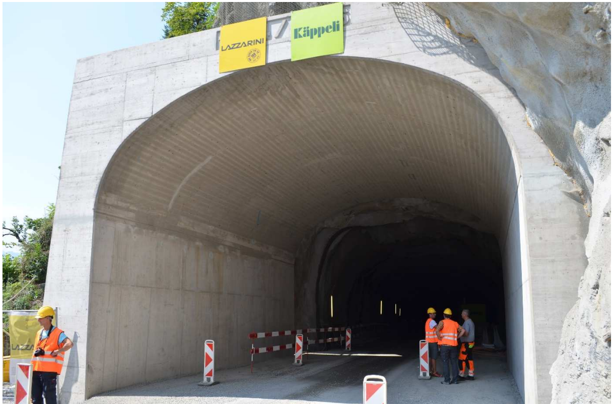
Fertig erstellter Vortunnel
