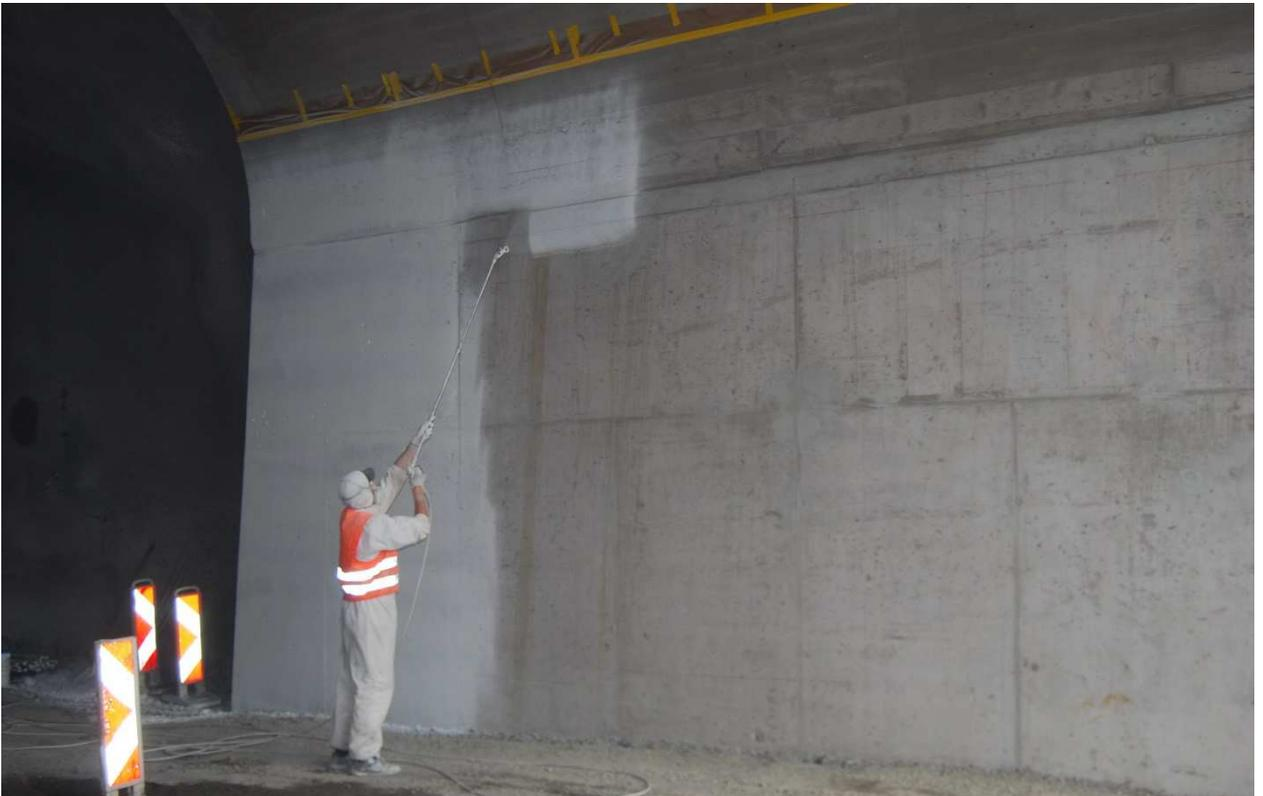
Bis auf ca. 4.5 m Höhe ab neuer Fahrbahn wird die die Innenfläche des Vortunnels gegen Tausalz geschützt (hydrophobiert) und für den besseren Unterhalt weiss beschichtet.
