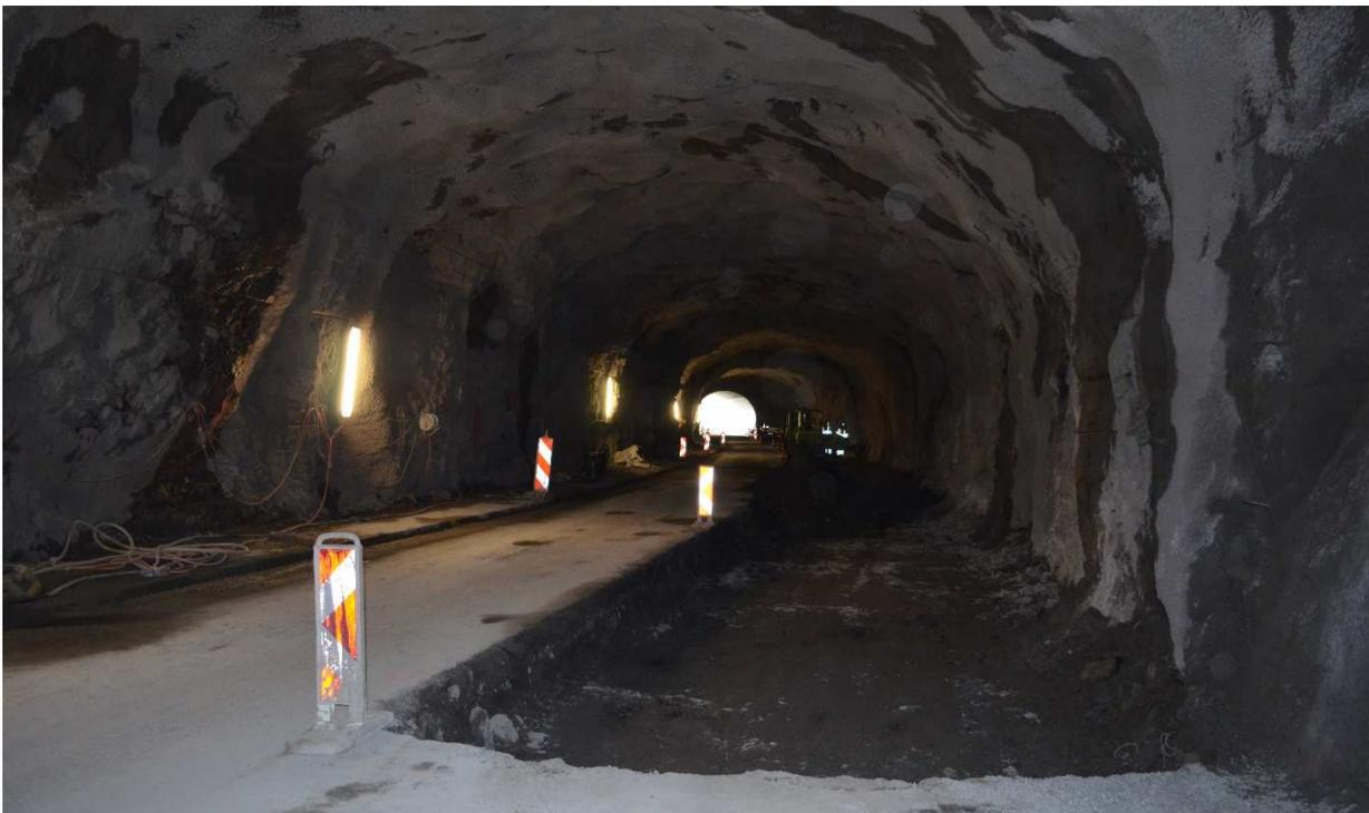
Die Fahrbahn im Tunnel wird in Etappen neu erstellt. In Fahrtrichtung Ried ist die bergseitige Fahrbahnhälfte ausgehoben. Anschliessend wird die Foundationsschicht eingebaut und später der Randabschluss versetzt.
