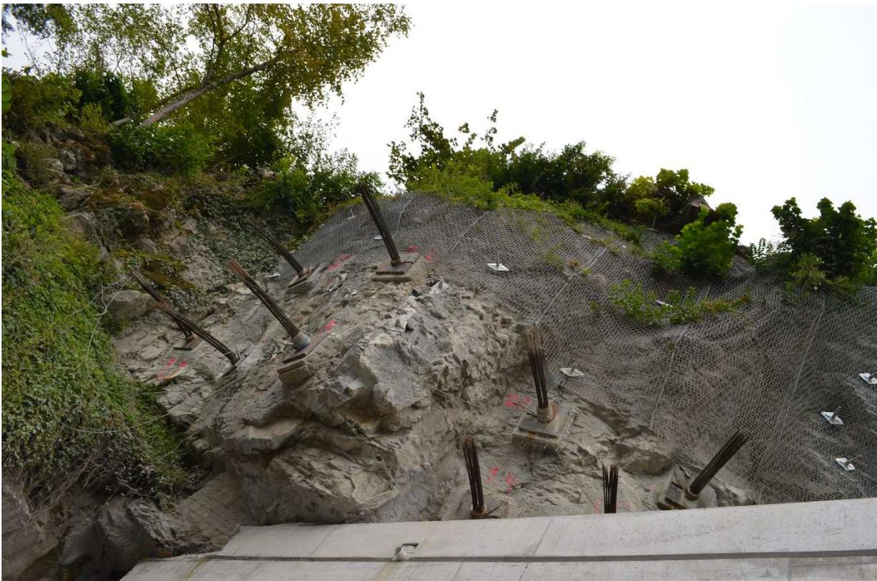
Die temporären Anker über dem Vortunnel werden entspannt und die Ankerköpfe entfernt.
