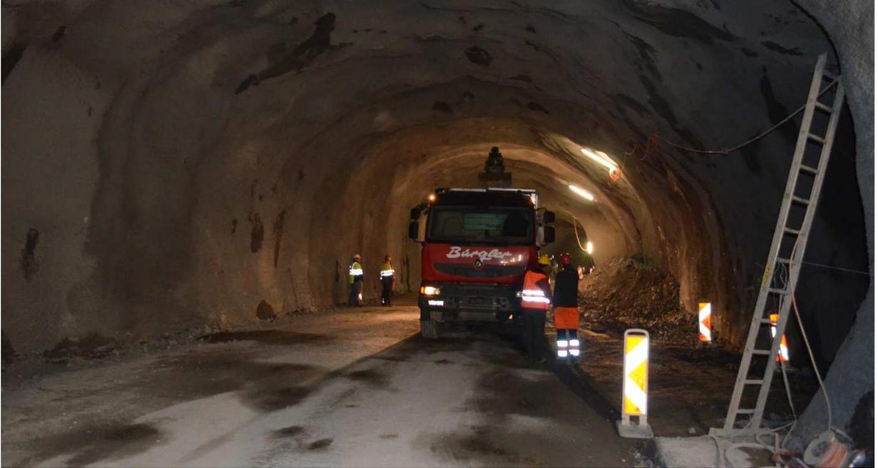
In der Mitte des Tunnels wird unter Verkehr das seitlich gelagerte Ausbruchmaterial der Querstollen aufgeladen und abtransportiert.
