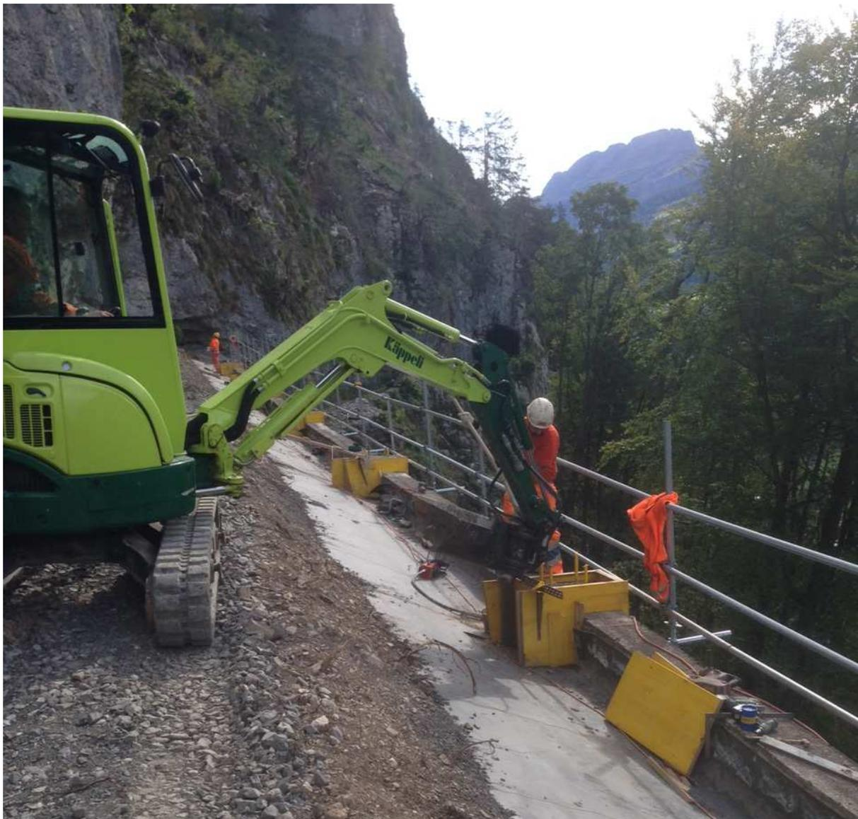
Schalen und Betonieren der Einzelfundamente auf der Galerie für die Streben der Steinschlagschutznetze.
