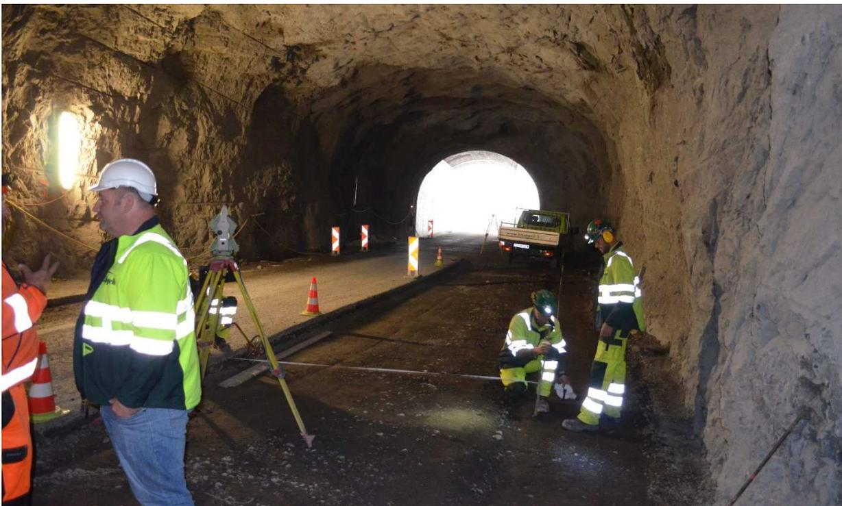
In Abschnitt wo die Foundationsschicht bereits eingebaut ist wird die Lage des neuen Randabschluss abgesteckt.
