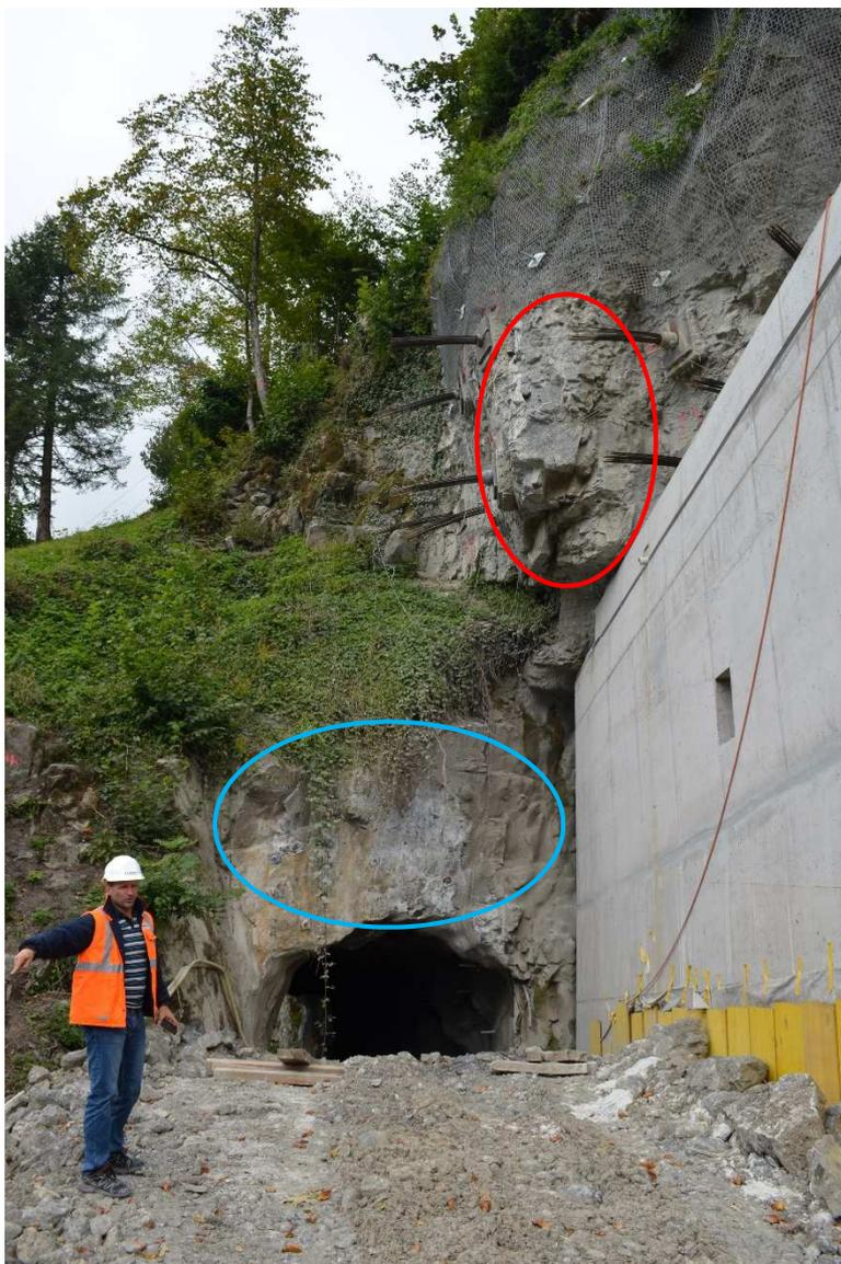
Die Felsnase (rot) über der alten Illgauerstrasse muss mit zusätzlichen permanenten Anker gesichert werden. Der Fels über dem Portal Tunnel alte Illgauerstrasse (blau) wird mit Anker und Spritzbeton gesichert. Für die Zugänglichkeit der Gerätschaften hat der Unternehmer eine temporäre Rampe geschüttet, welche nach den Ankerarbeiten wieder entfernt wird.
