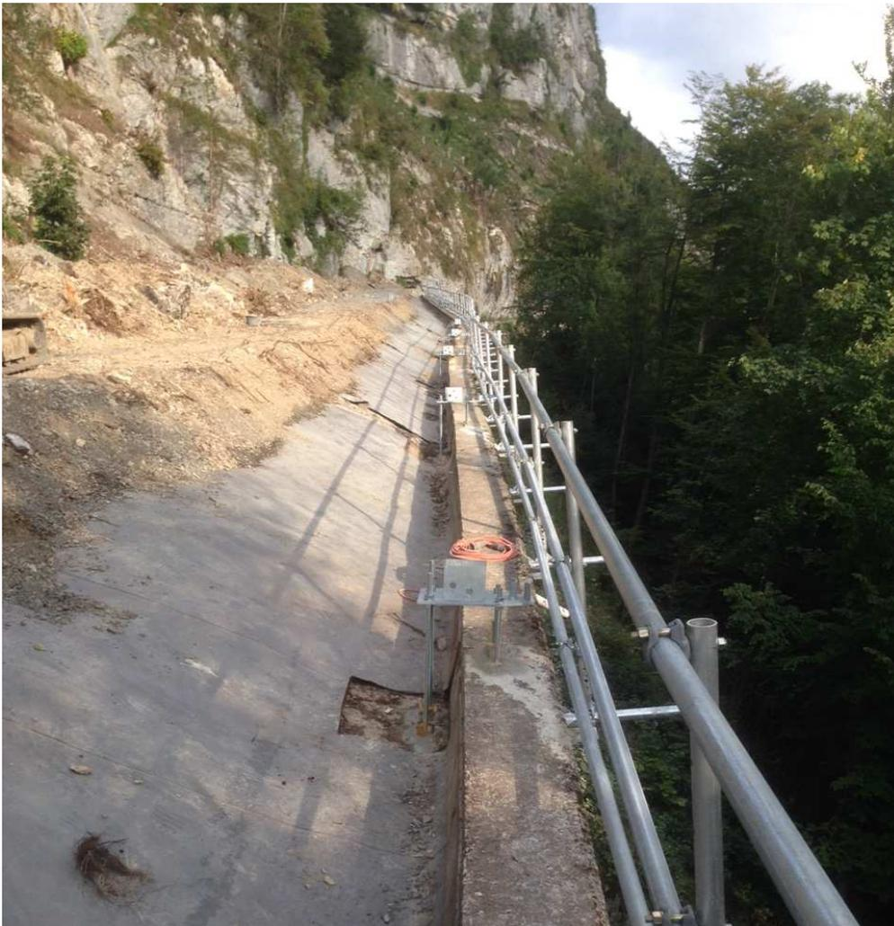
Auf der Galerie wurde eine Transportpiste erstellt und zur Kontrolle die bestehende Abdichtung frei gelegt. Im Abstand von ca. 8m werden Gewindestangen für die neuen Einzelfundamente der Steinschlagschutznetze versetzt.
