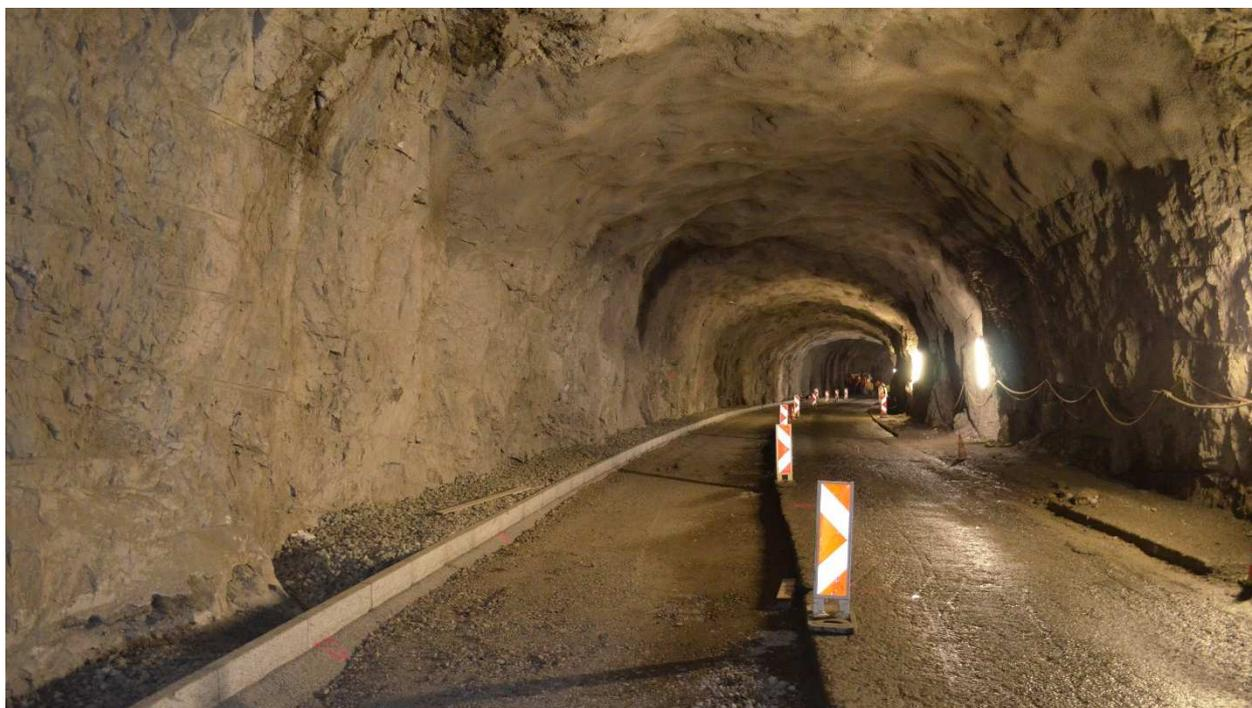
Die linke Fahrbahnhälfte (Blick Fahrtrichtung Illgau) ist soweit vorbereitet, dass Anfangs November 2015 die Tragschicht (Belag) eingebaut werden kann. Bereits im November 2015 beginnen die Arbeiten auf der rechten Fahrbahnhälfte.
