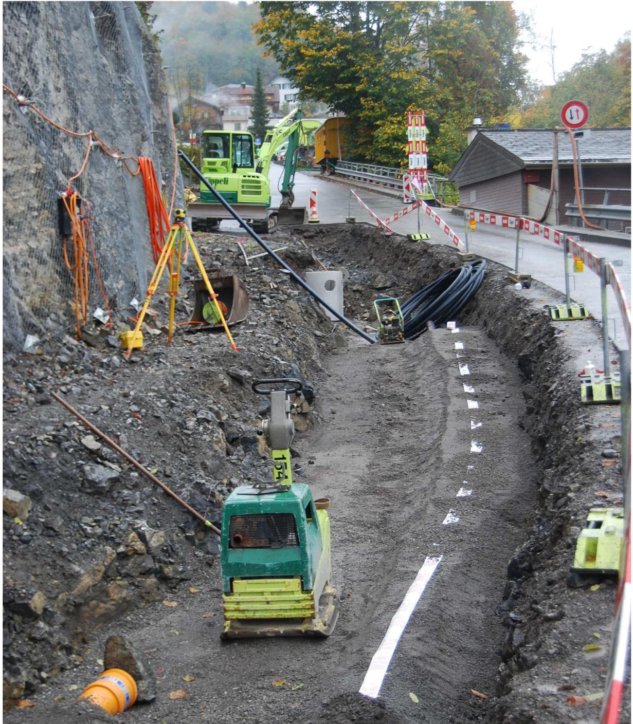
Auf der bergseitigen Fahrbahn (Fahrtrichtung Ried) werden die Werkleitungen (Kabelrohrblock) und die Strassenentwässerung erstellt.
