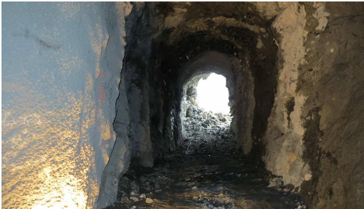
Licht am Ende des Tunnels! Der Durchschlag ist geschafft. Nun erfolgen die Sicherungsarbeiten (punktuelle Spritzbetonarbeiten) und die Arbeiten am Trassee (Kabeltrasse, Fahrbahn). Durch die Querstollen werden die Fussgänger/Radfahrer via Tunnel künftig um das Rutschgebiet geführt. Die Querstollen dienen gleichzeitig als Fluchtstollen des Strassentunnels.
