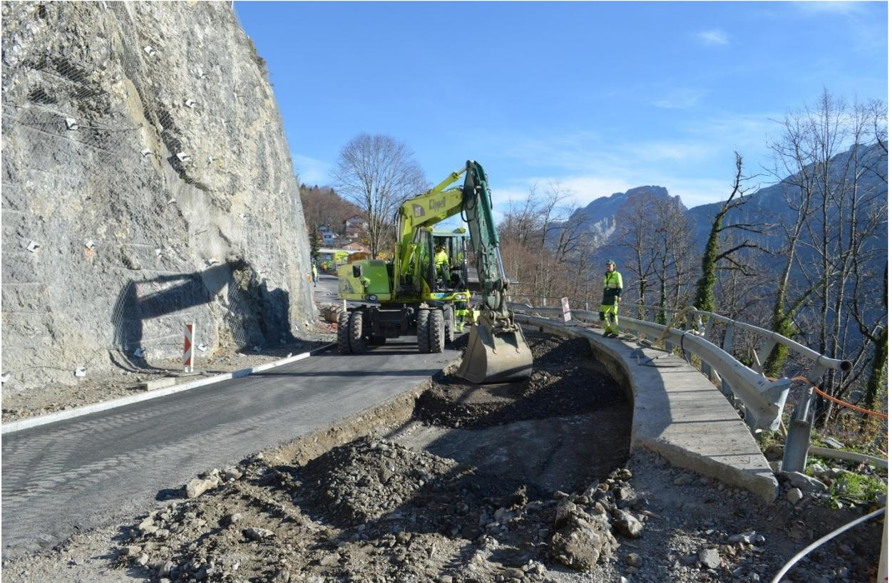
Einbau der Fundationsschicht der Fahrbahn Fahrtrichtung Illgau.
