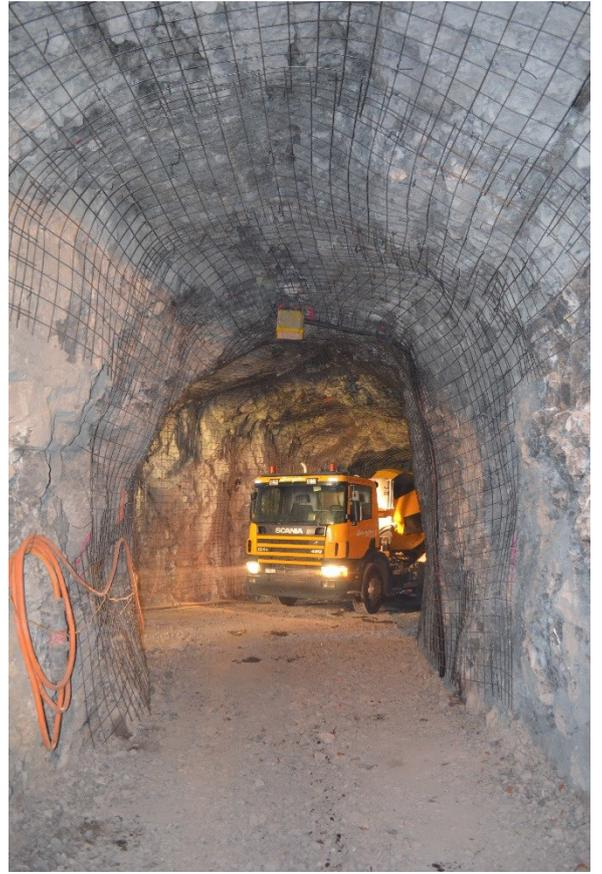
Die Querstellen vom Tunnel Illgau auf die alte Illgauerstrasse sind ausgebrochen und gesichert. Mit LKW's wird in Rückwärtsfahrten der Spritzbeton angeliefert. Die Stollen sind im Kopfbereich teilweise mit Armierungsnetzen gesichert. In regelmässigen Abständen werden Steigleitungen für die Beleuchtung eingebaut.
