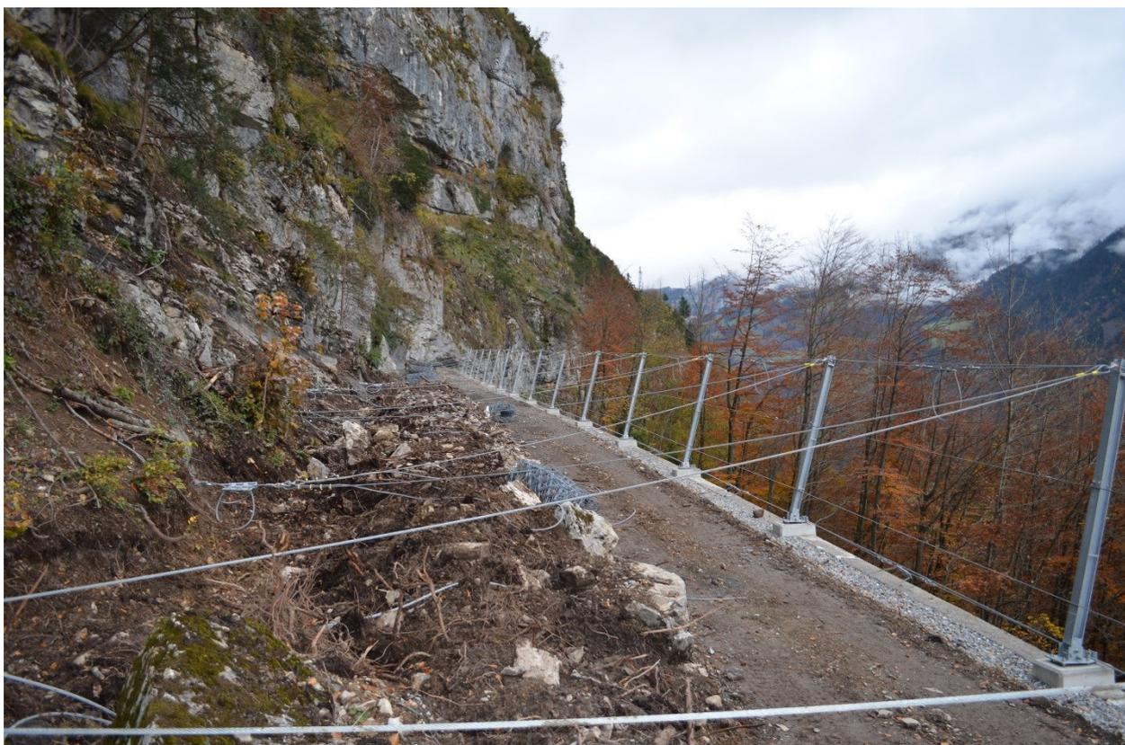
Die neuen Stützen und Abspannungen sind bereit für die Montage der Steinschlagschutznetze auf der Galerie.
