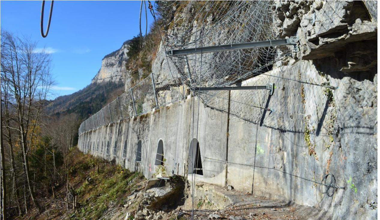
Blick von der alten Illgauerstrasse auf die Galerie. Die Steinschlagschutznetze auf der Galerie sind montiert.
