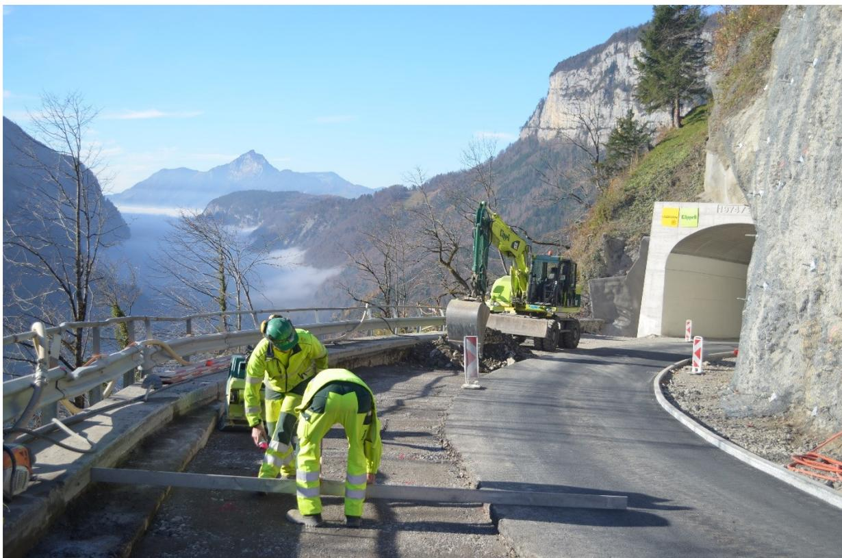
Fahrtrichtung Muotathal ist die Fahrbahn mit allen Werkleitungen erstellt und kann befahren werden. Zurzeit wird der Oberbau (Fundationschicht) der Fahrbahn Richtung Illgau neu erstellt. Die bestehende Leitschranke wird später ebenfalls ersetzt. Das Schutznetz auf der Kurveninnenseite wird nicht bepflanzt oder mit Spritzbeton abgedeckt.
