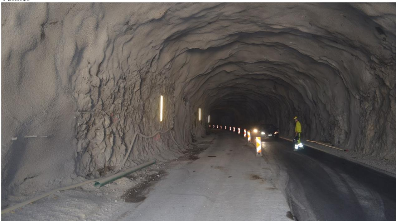
Im Tunnel ist auf der Fahrtrichtung Muotathal der Randstein und der Belag (Tragschicht) eingebracht.
