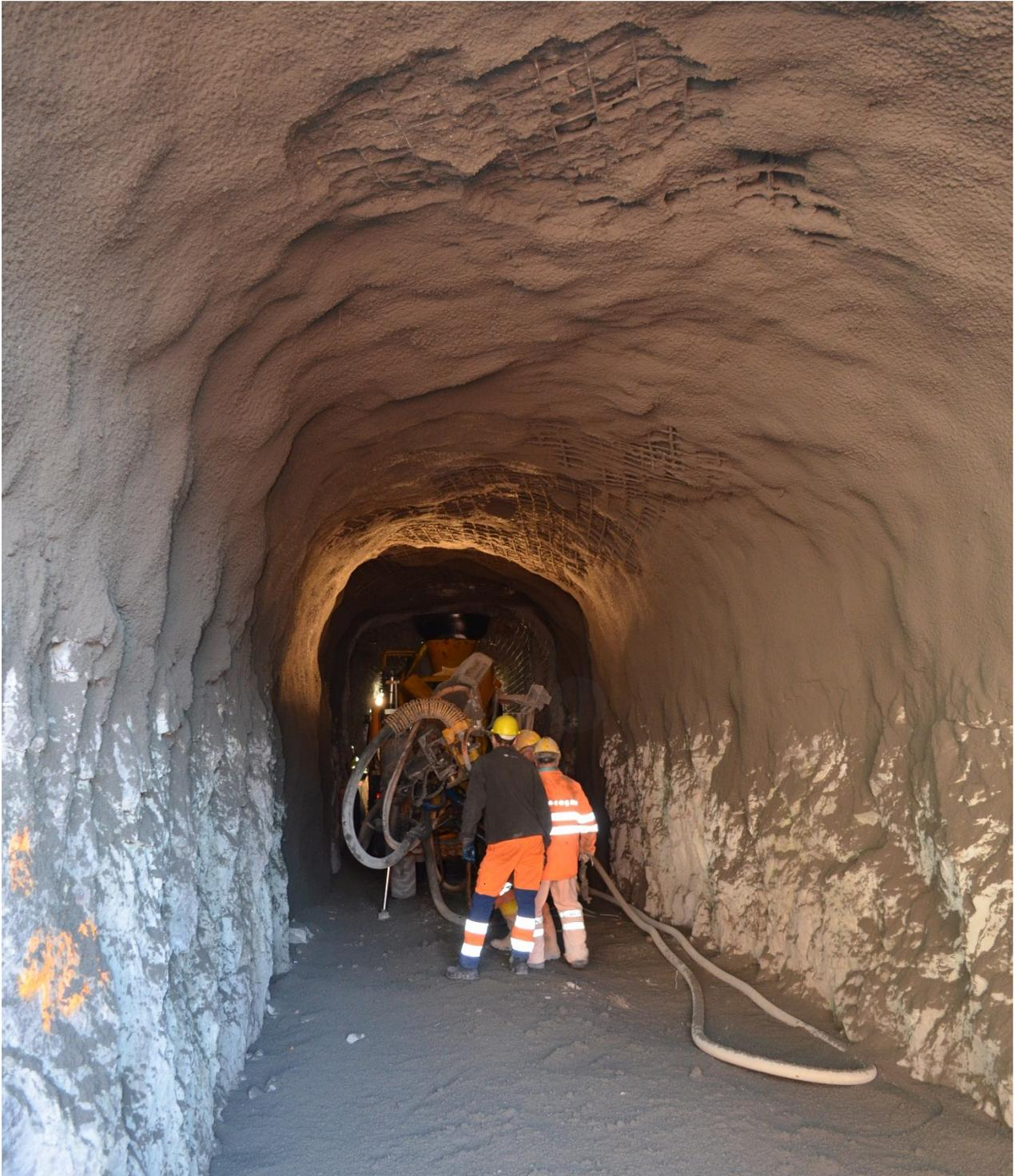
Die Querstollen werden teilweise mit Spritzbeton ausgekleidet.
