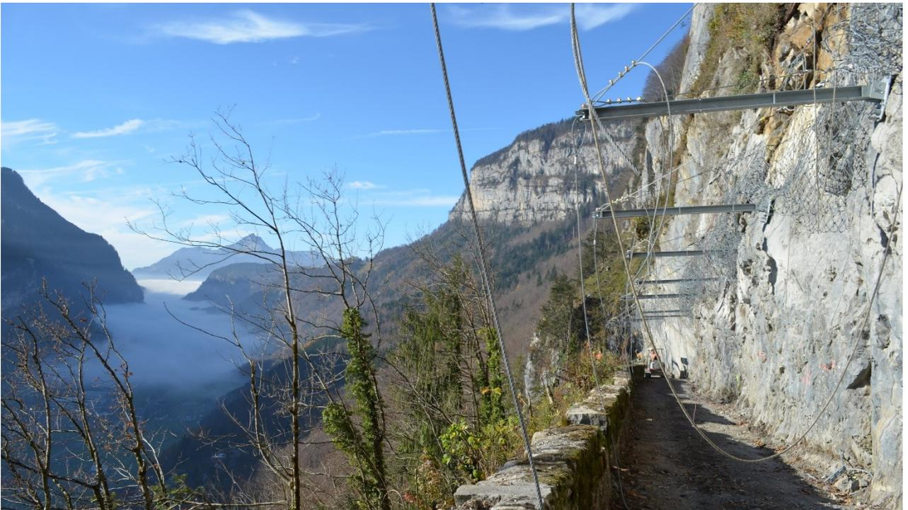
Auf der alten Illgauerstrasse werden die Steinschlagschutznetze montiert.
