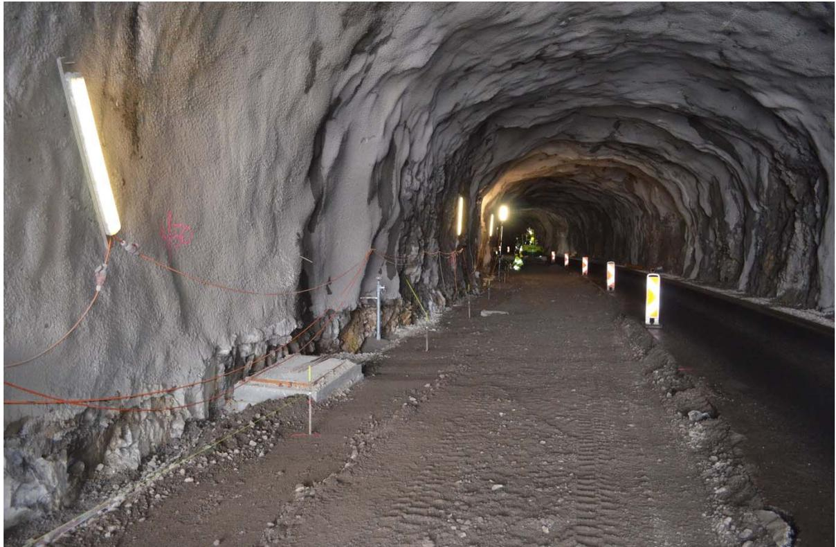
Die Kabeltrasse für die Elektroinstallationen, die Entwässerungsleitungen und die Fundation der Strasse sind erstellt.
