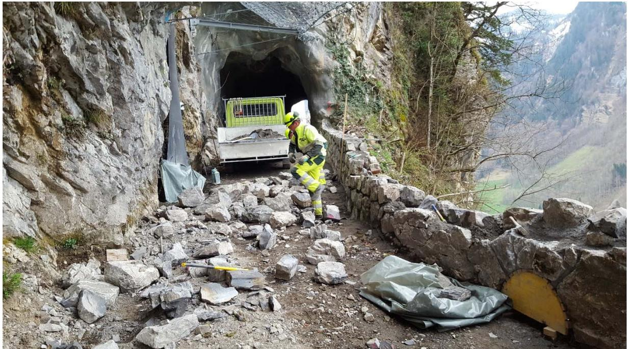
Instandsetzung der bestehenden Bruchsteinmauer Alte Illgauerstrasse. In Handarbeit müssen die Steine zugehauen und eingepasst werden.
