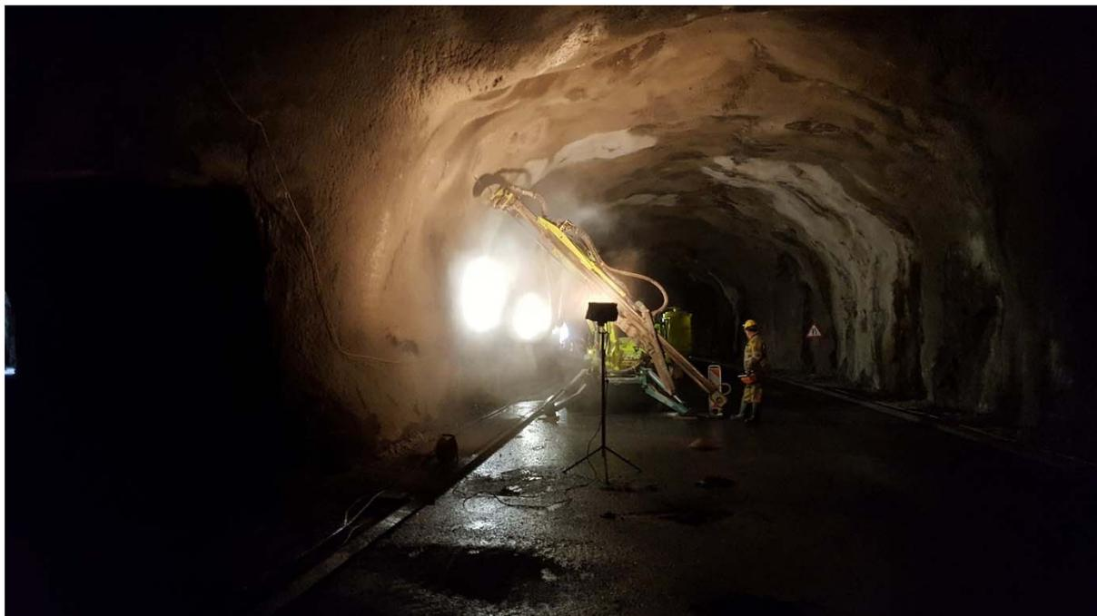
Bei einzelnen Feucht- resp. Nassstellen im Tunnelgewölbe werden Bohrungen zur Entlastung/Drainage erstellt.
