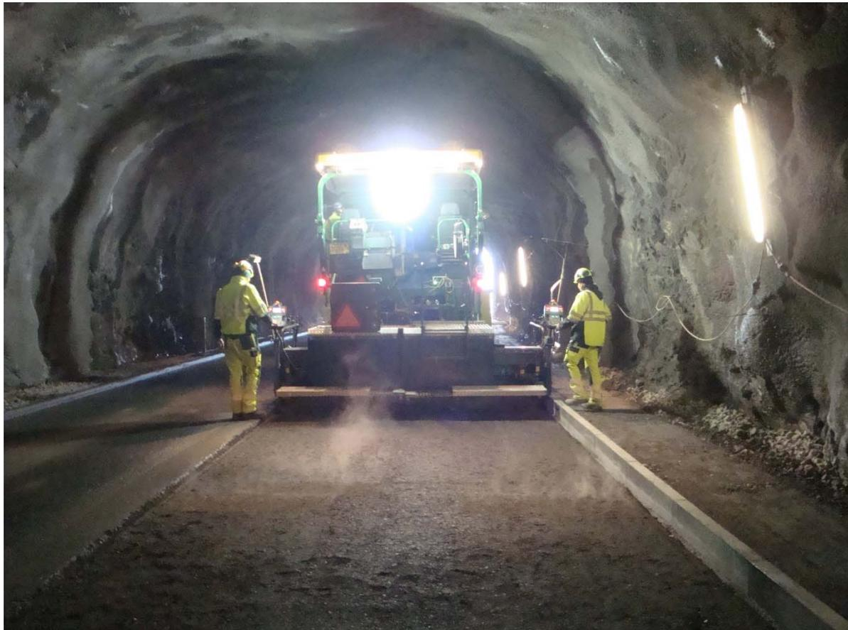
Belageinbau Fahrbahn und Bankett im Tunnel.
