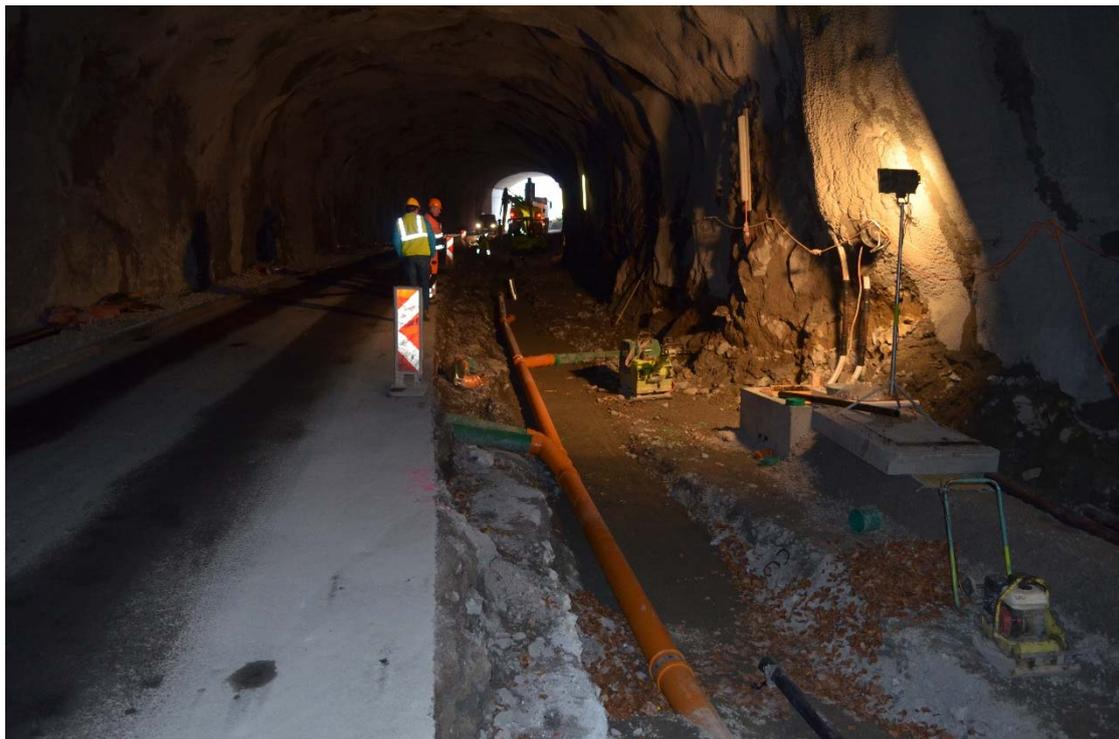
Neu verlegte Sammelleitung für die Strassen-/Tunnelentwässerung und Kabelrohrblock im Tunnel.
