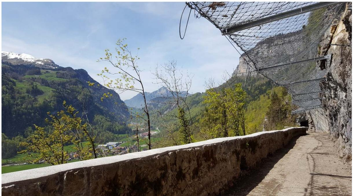
...Nachher. Die instandgesetzte Bruchsteinmauer mit Rohplanie. Fehlt noch der Handlauf und der Belag.
