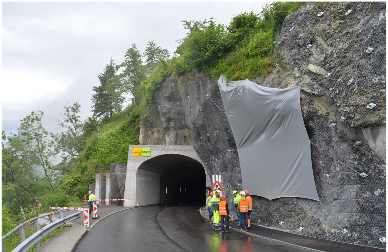
16.06.2016: Vortunnel mit Eisschlagschutzmembrane zum Schutz der Fussgänger vor Tropfwasser und Eisschlag.
