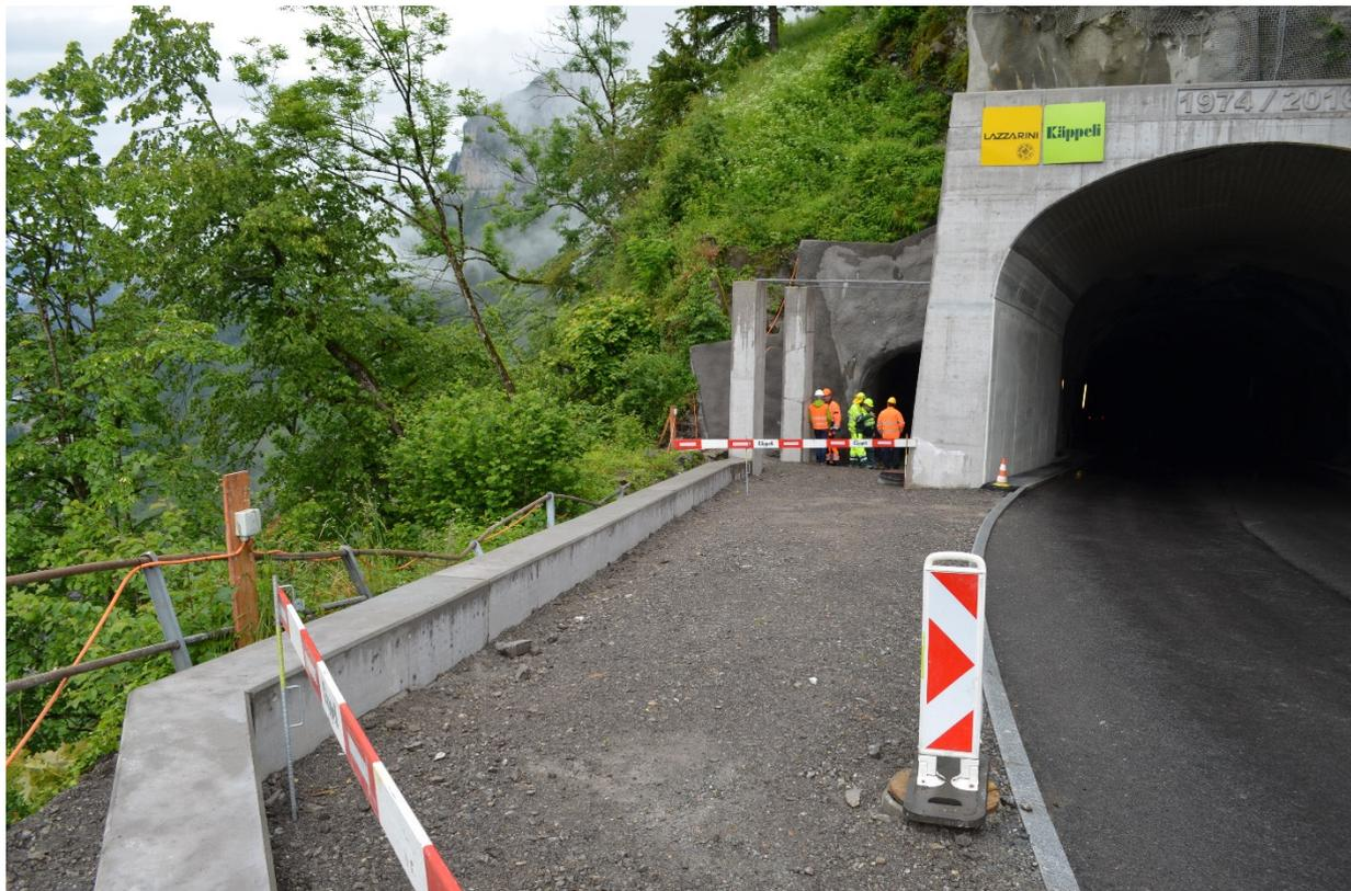
16.06.2016: Vortunnel mit neuen Fundamenten für Geländer und Betonstützen für Salzsilo.
