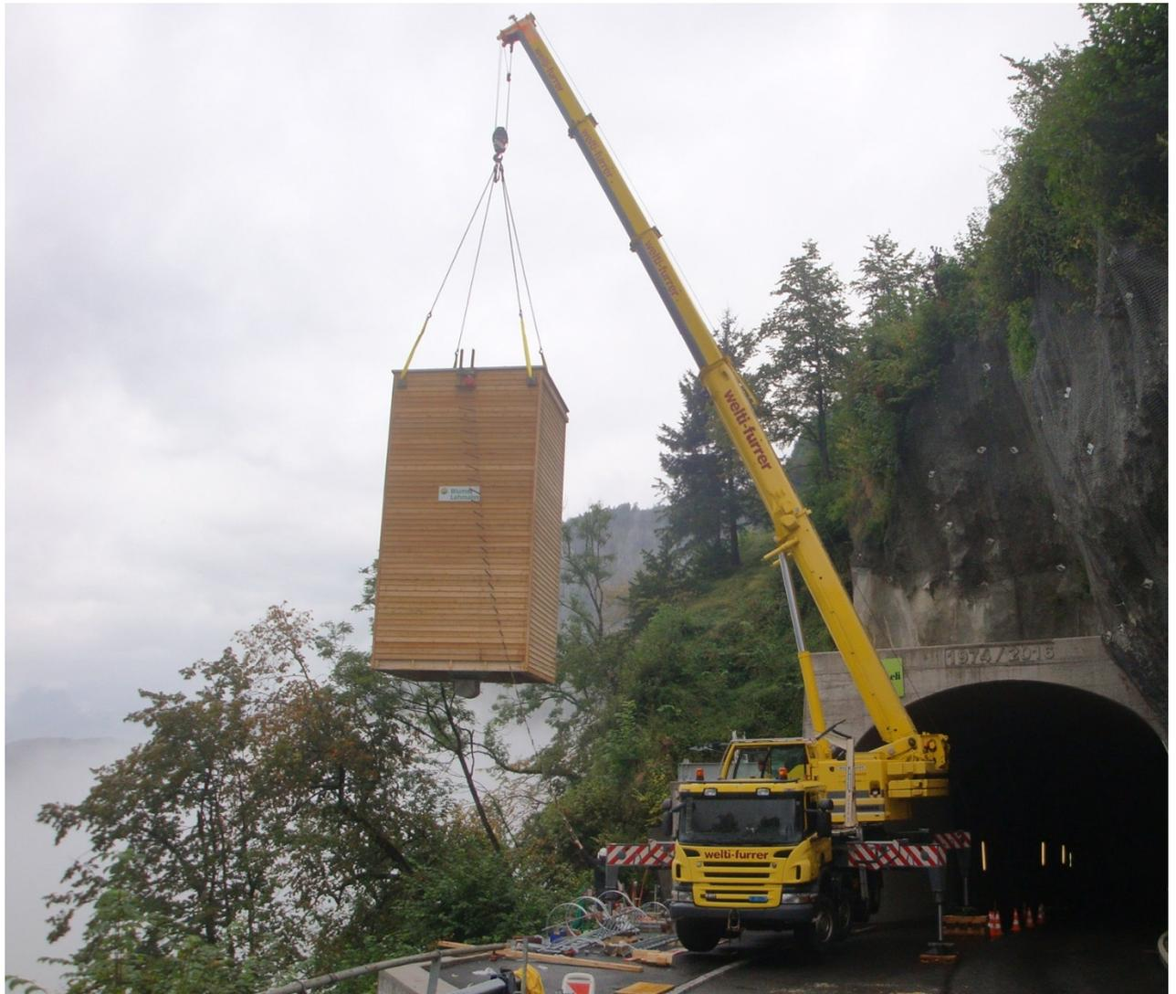
29.08.2016: Einheben des Silos auf die vorbereiteten Stützen
