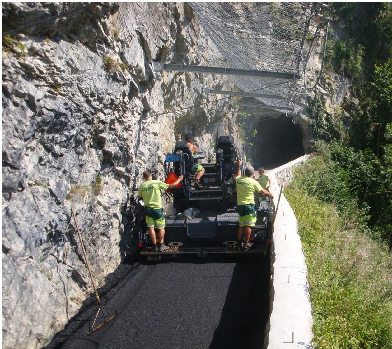
16.08.2016: Deckbelagaeinabu mit Fertiger auf der alten Illgauerstrasse. Gleichzeitig wird die bergseitige Rinne für die Ableitung des Oberflächenwassers erstellt.
