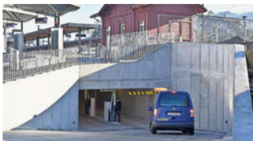
Die Tiefgarage des Bahnhofs Arth-Goldau wurde Ende Dezember 2020 eröffnet.
