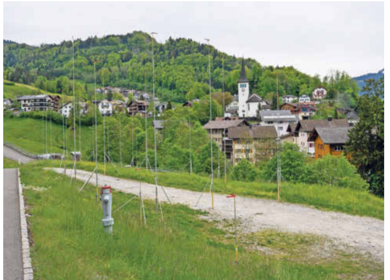
Die Bauprofile weisen auf den Bau der zwei Mehrfamilienhäuser hin. Es entstehen zehn neue Wohnungen. Bild: Erhard Gick
